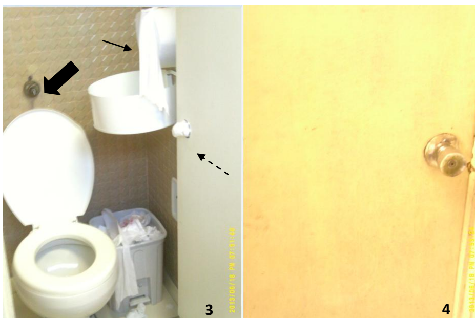
FIGURAS 3 e 4. Na figura 3, banheiro feminino térreo direito, a seta normal aponta a presença de papel higiênico no banheiro feminino analisado. Já a seta pontilhada indica a ausência de maçaneta na porta da subdivisão 2 do mesmo banheiro e a seta espessa mostra a ausência do
