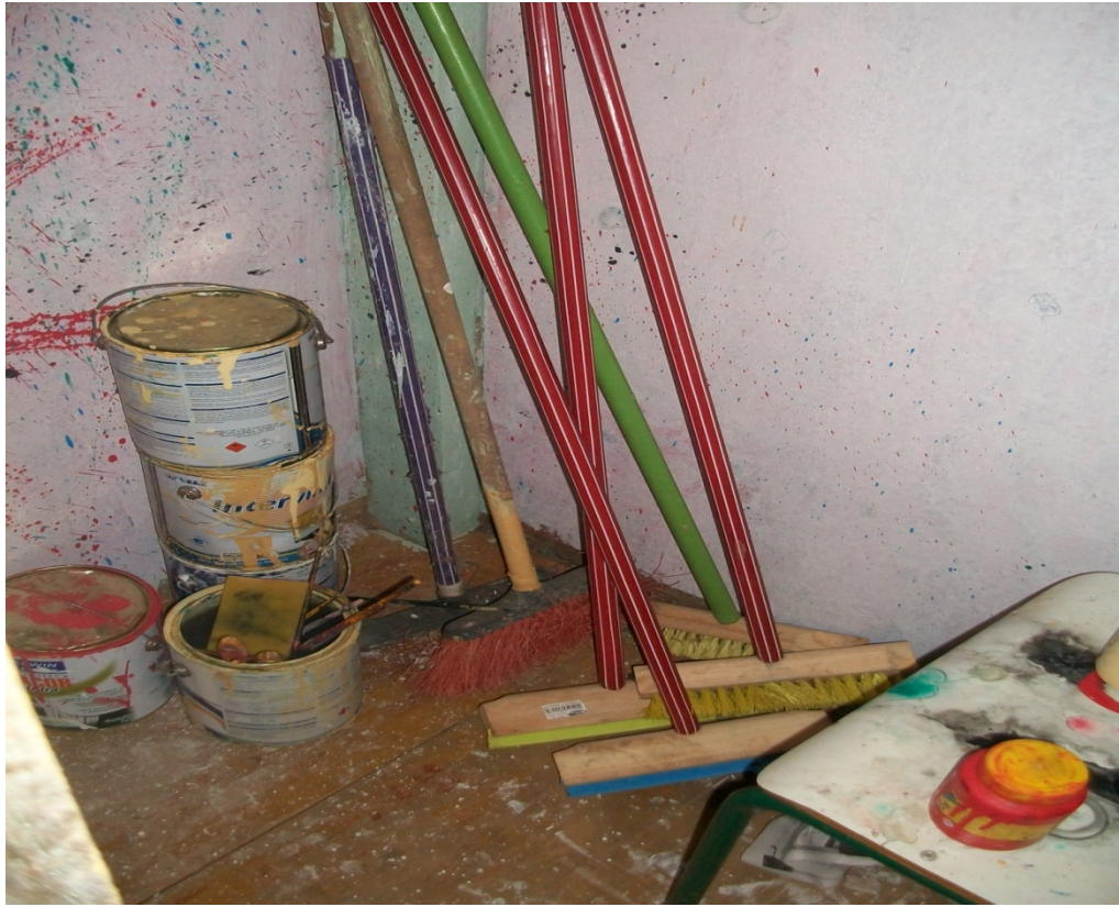
Dia da reforma na escola
