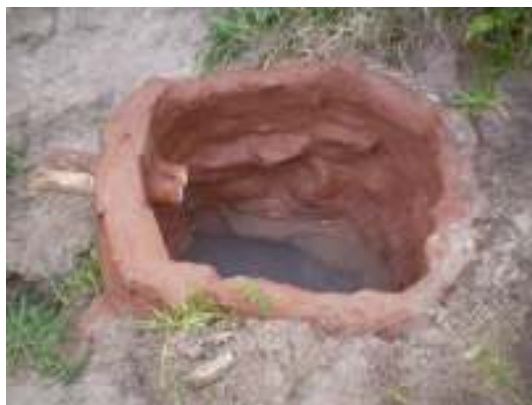
Figura 4 – Barreira de solo cimento e pedras em torno da nascente.
