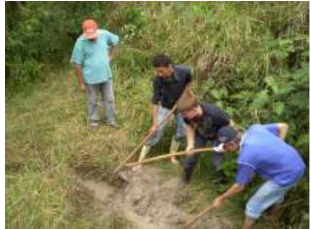
Figura 3. Limpeza e desobstrução da nascente 1
