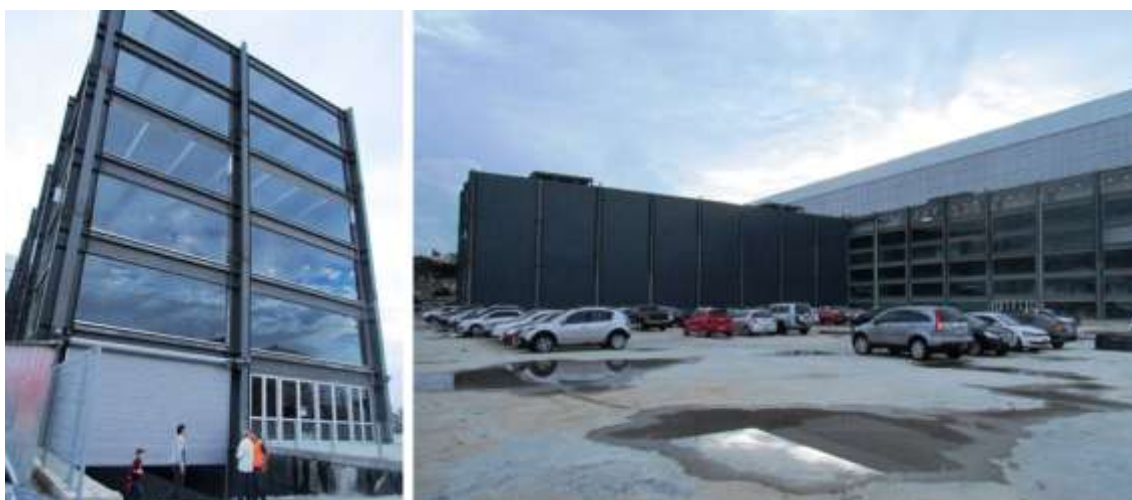
FIGURA 36 – PRÉDIO DE MÍDIA E ESTACIONAMENTO EXTERNO
