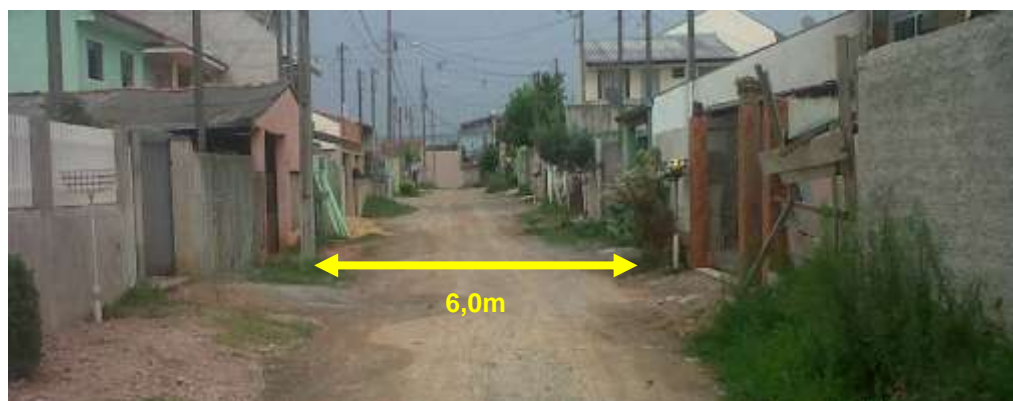
Figura 4.31 – Município de Pinhais, vista das condições geométricas da via sem nome, entre as ruas Rio Iguazu e Rio Solimões Fonte: o Autor (2014)
