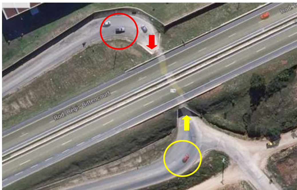
Figura 4.29 – Município de Colombo, trânsito nos dois sentidos na trincheira da Rua Dezenove de Novembro com a BR 476
