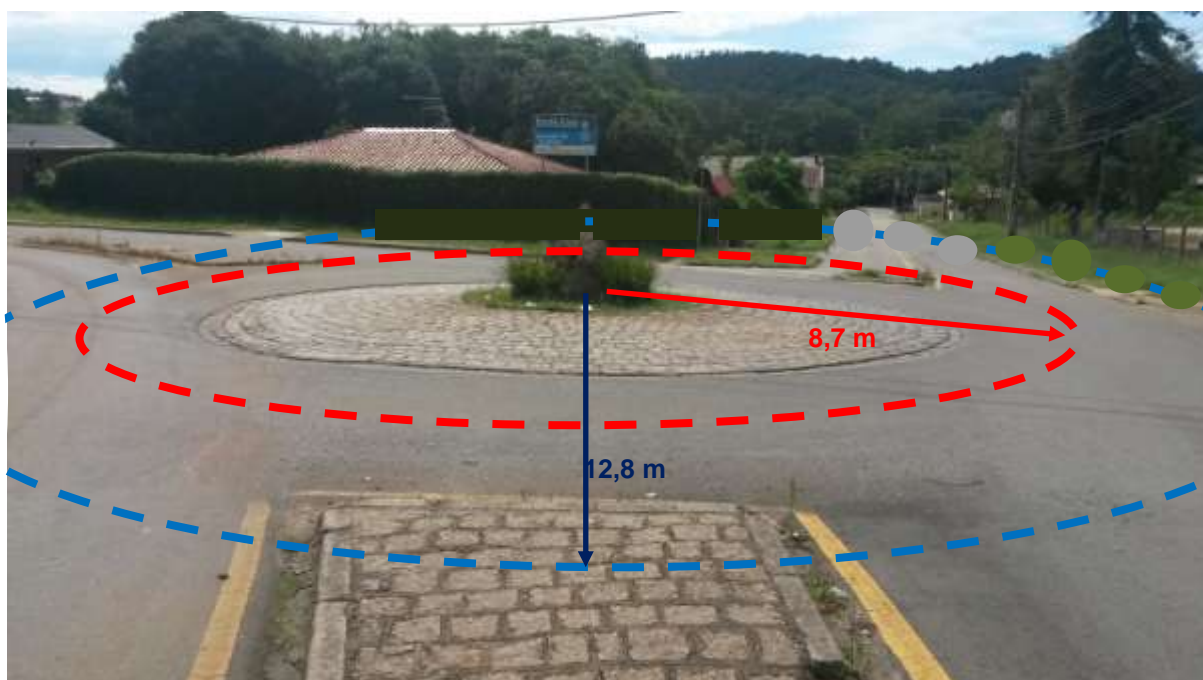
Figura 4.12 – Município de Almirante Tamandaré, vista do traçado do raio de giro na rótula da Rua Antônio Batista de Siqueira com a Rua Bertolina Kendrich de Oliveira Fonte: Google maps, adaptado pelo Autor (2014)
