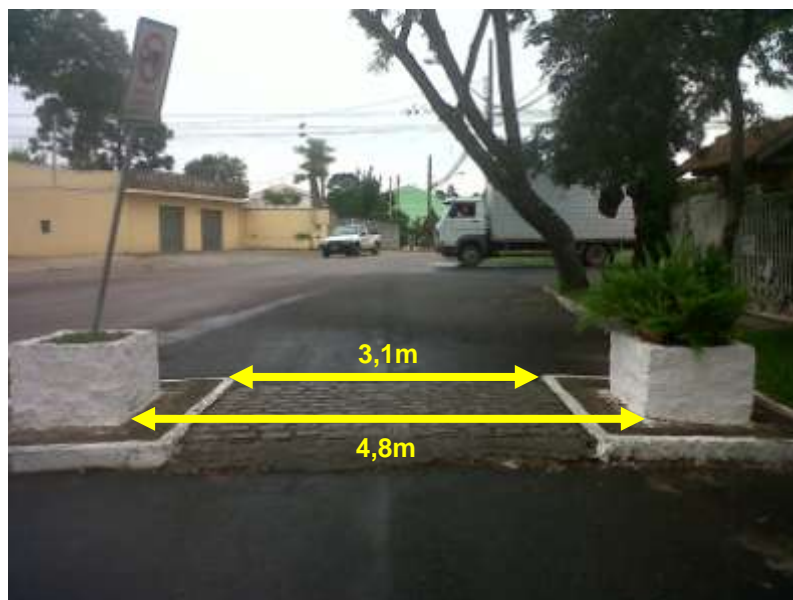
Figura 4.37 – Município de Pinhais, largura útil em função do obstáculo na rua Renascença Fonte: o Autor (2014)
