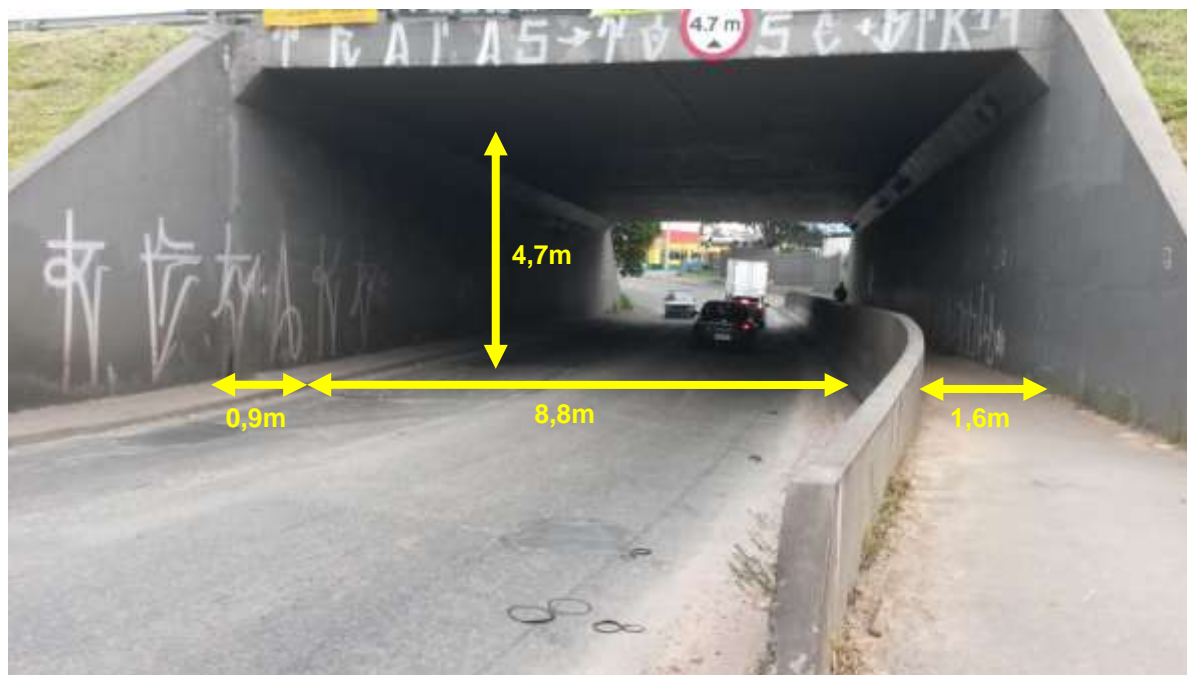
Figura 4.27 – Município de Colombo, dimensões da trincheira da Rua Jacob Mehl com a BR 476 Fonte: o Autor (2014)
