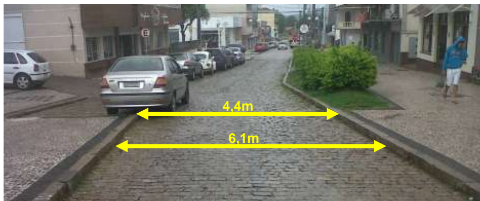
Figura 4.26 – Município de Colombo, redução na largura útil da Rua Quinze de Novembro
