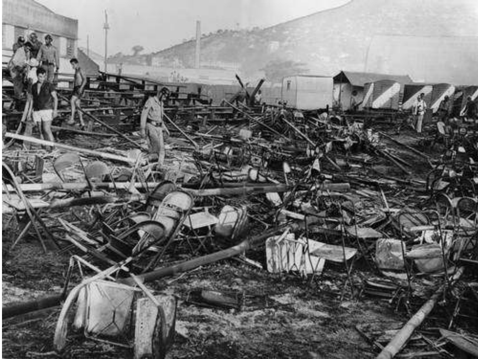
Figura 2.1 – Gran Circo após a ocorrência de um incêndio em 1961 Fonte: Seito et. al. (2008).
