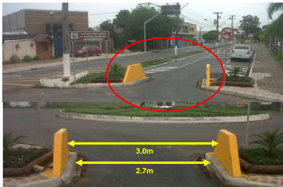
Figura 4.33 – Município de Pinhais, obstáculo na rótula do encontro das ruas 24 de Maio e Guilherme Weiss Fonte: o Autor (2014)
