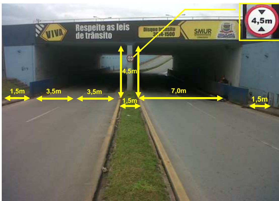
Figura 4.16 – Município de Araucária, trincheira da Rua Manoel Ribas com a BR 476 Fonte: o Autor (2014)
