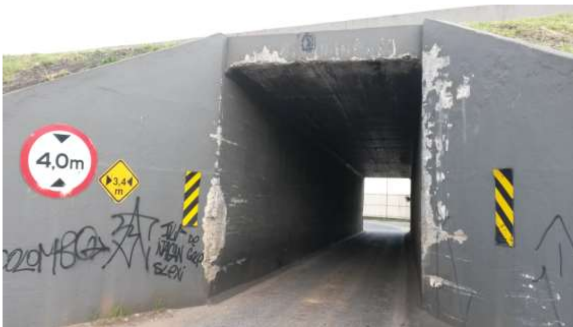
Figura 4.28 – Município de Colombo, trincheira da Rua Dezenove de Novembro com a BR 476 Fonte: o Autor (2014)
