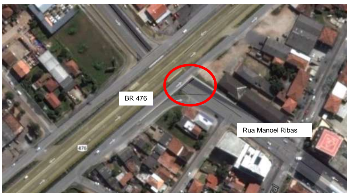
Figura 4.15 – Município de Araucária, trincheira da Rua Manoel Ribas com a BR 476 Fonte: Google maps, adaptado pelo Autor (2014)
