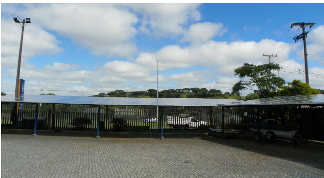
Figura 13 - Instalação dos Painéis Fotovoltaicos Integrados ao Telhado do Estacionamento
