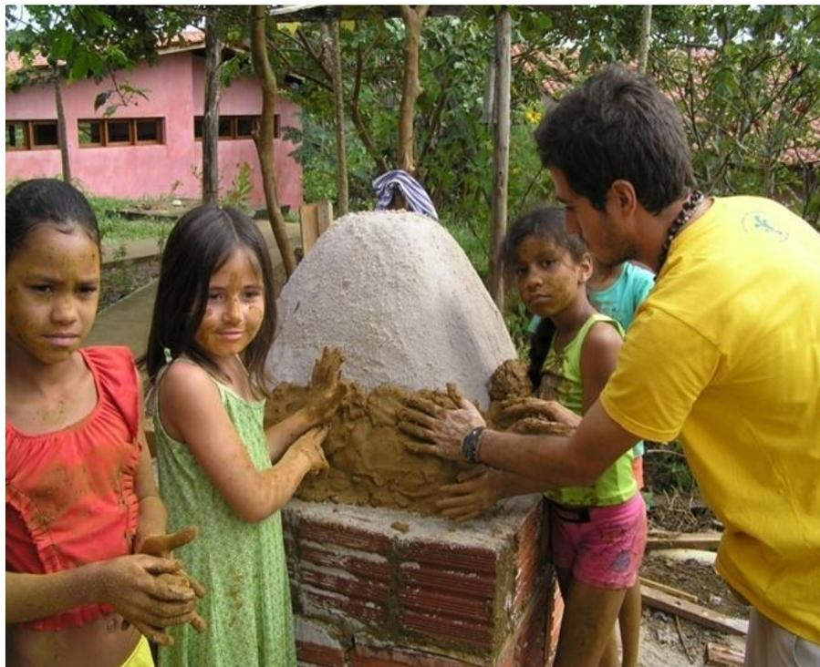
**FIGURA 12: CONSTRUINDO O FORNO DE BARRO.**
