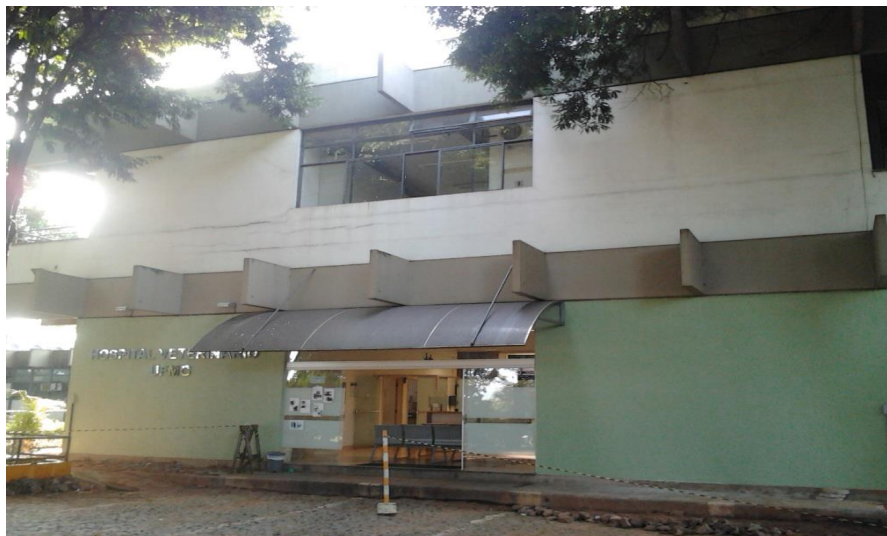
Figura 01 – Vista frontal da fachada do prédio principal do Hospital Veterinário– UFMG/ Belo Horizonte – MG, (FONTE: Hospital Veterinário UFMG, 2014).
