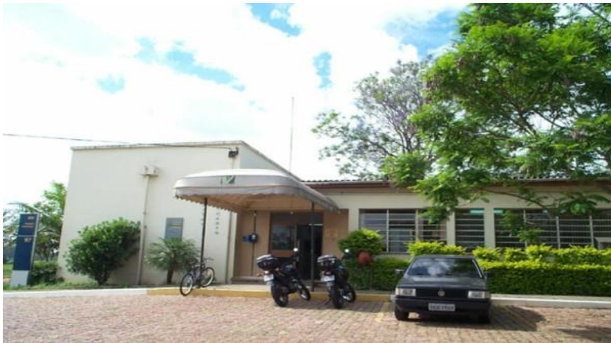
Figura 11 - Vista frontal da fachada do prédio principal do Hospital Veterinário – UFSM/ Santa Maria – RS. (FONTE: Hospital Veterinário Universitário da UFSM, 2014)
