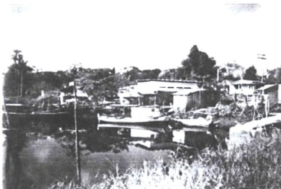
Figura 2: Bairro do Carijo, localizado na ilha de Cananéia
