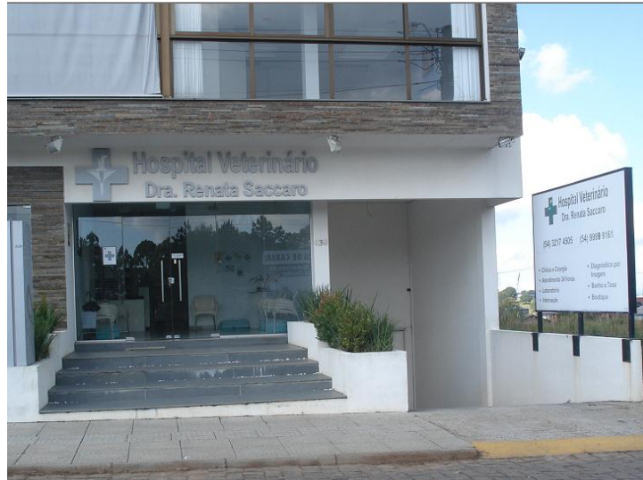
FIGURA 1. Vista da fachada do Hospital Veterinário Dr a Renata Saccaro.
