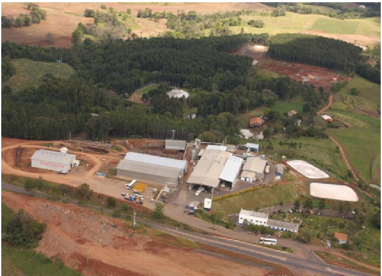
FIGURA 1 – Vista aérea da Cooperoeste/Terra Viva, unidade de armazenamento e processamento do leite, situada em São Miguel do Oeste SC, onde foi desenvolvido o estágio curricular obrigatório no período de 01 de agosto a 28 de setembro de 2012 (Fonte: www.terravivasc.com.br . Acesso em: 17/09/2012).
