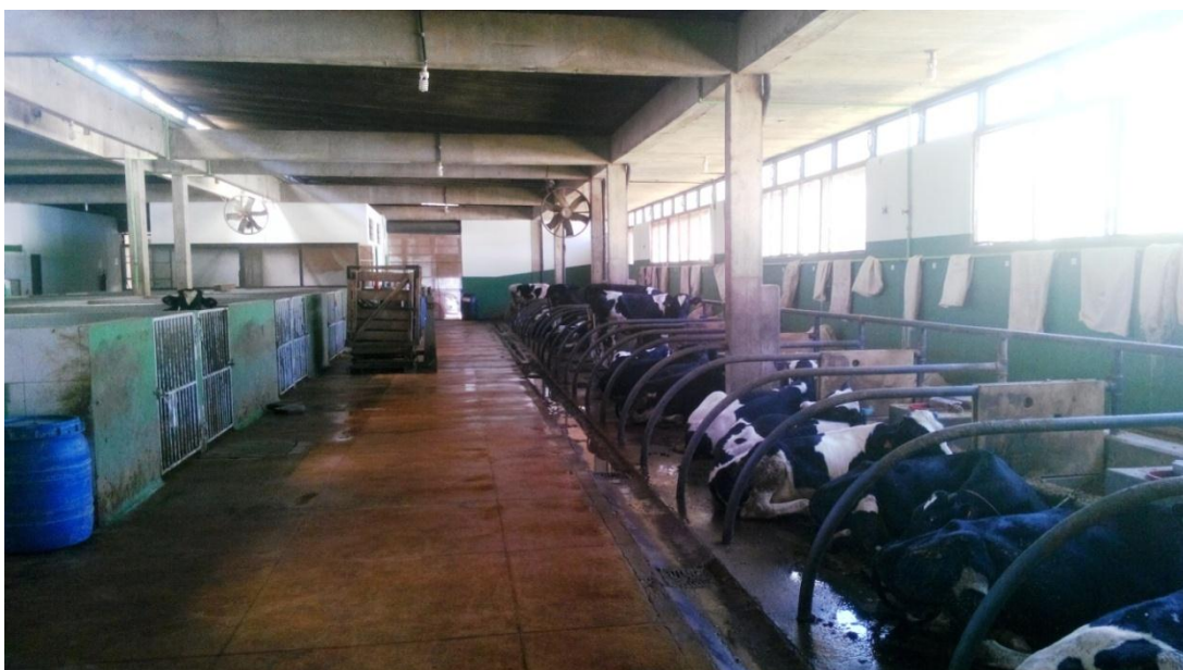
Figura 5 -Vista lateral das instalações do bloco de Clínica Médica de Ruminantes da Escola de Veterinária da UFMG, Tie- stall à direita e baias individuais de pequenos ruminantes à esquerda
