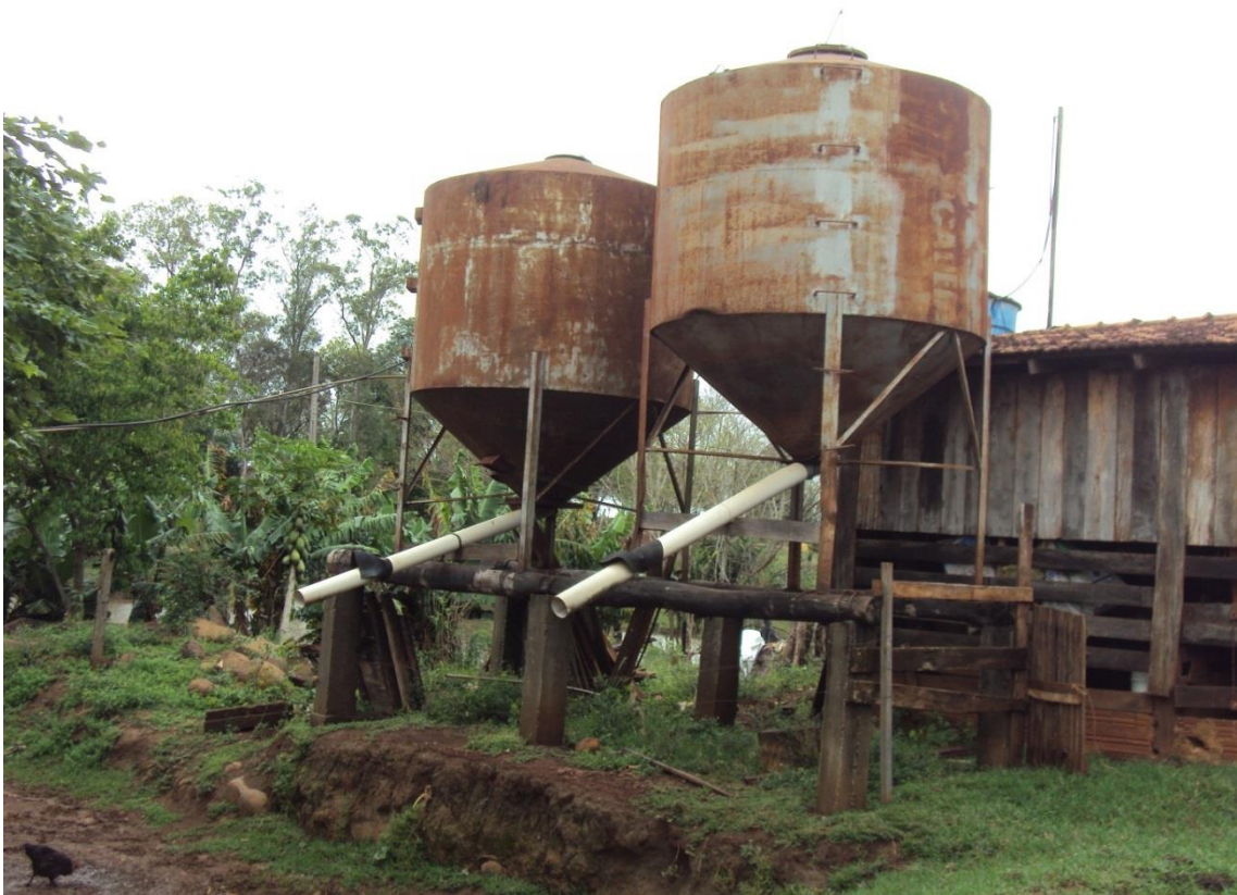
Fig.3 Silo para armazenamento da ração.(Fonte: Autor)
