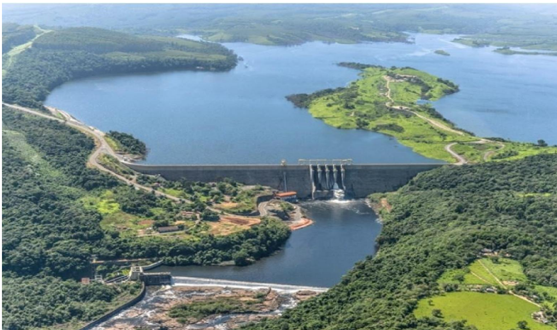
IMAGEM 4 – A USINA EM OPERAÇÃO - 2013 FONTE: Consórcio Cruzeiro do Sul
