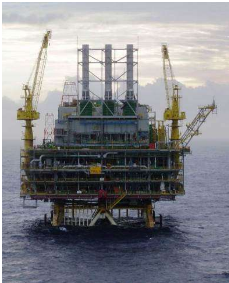
Figura 5: Plataforma PRA1 instalada na Bacia de Campos (TECHINT, 2010).
