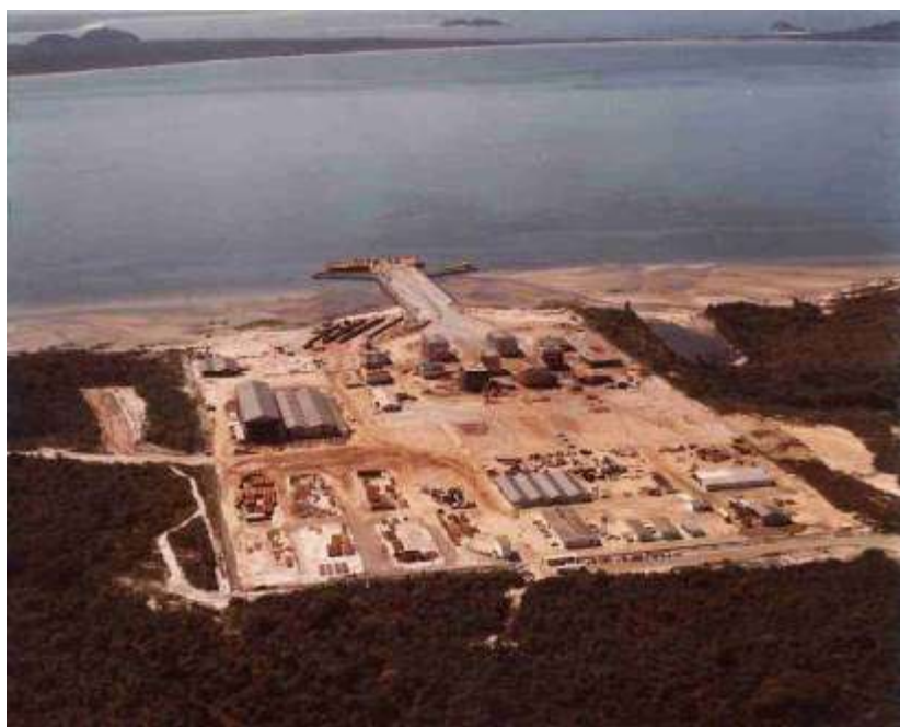
Figura 2: Foto do pátio de obras da Techint no ano de 1984 (TECHINT, 2010)
