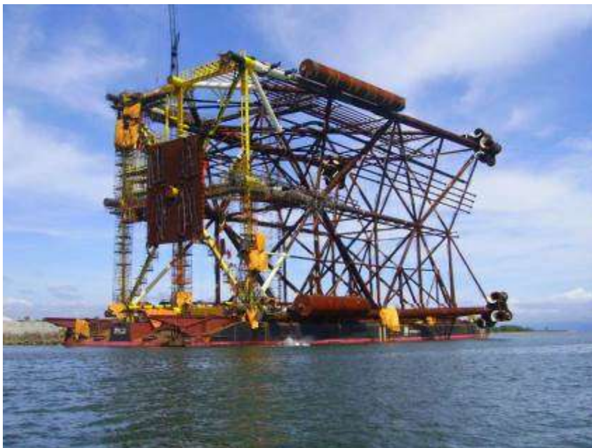
Figura 4: Plataforma PRA1 sobre a balsa de transporte (TECHINT, 2010).
