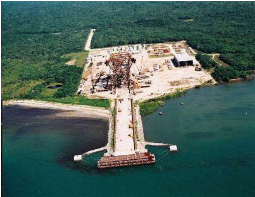
Figura 3: Foto do pátio de obras da Techint no ano de 2007 (TECHINT, 2010).
