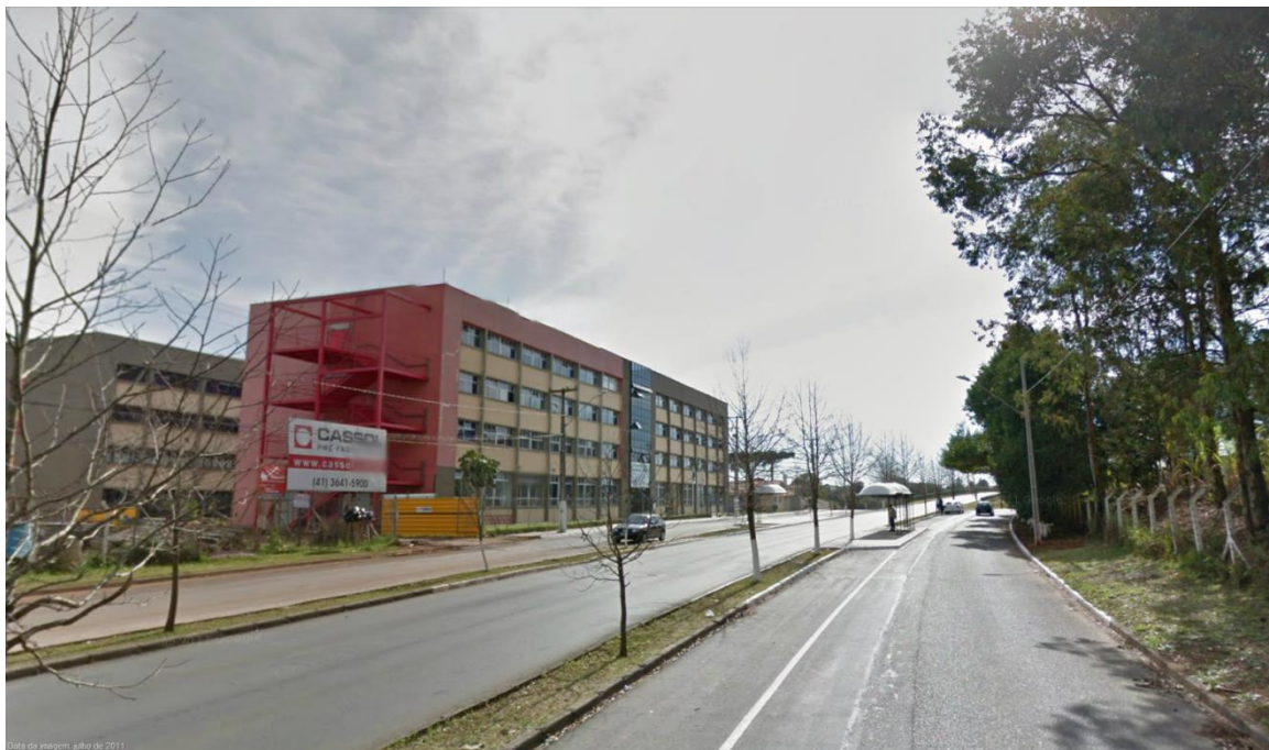
FIGURA 25 - RUA DEPUTADO HEITOR ALENCAR FURTADO SENTIDO CENTRO, PRÓXIMO À ESQUINA R. ROGÉRIO PEREIRA DE CAMARGO fonte: inav/geosistemas srl, 2009 in Google Maps, (Google, 2013)
