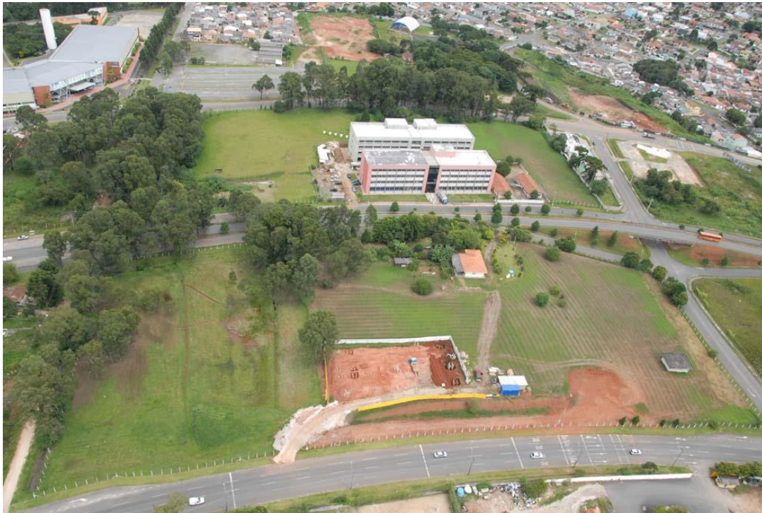
FIGURA 32 - FOTO AÉREA DO INÍCIO DA CONSTRUÇÃO DO BLOCO N, EM OUTUBRO DE 2006, COM VISTA DA PROF. PEDRO VIRIATO PARIGOT DE SOUZA Fonte: (UTFPR, 2013).
