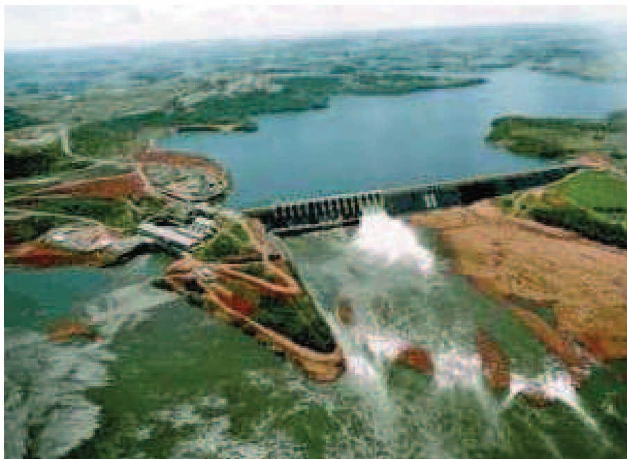
Figura 8 – Foto aérea da Usina Hidrelétrica Governador José Richa Fonte: COPEL (2012)
