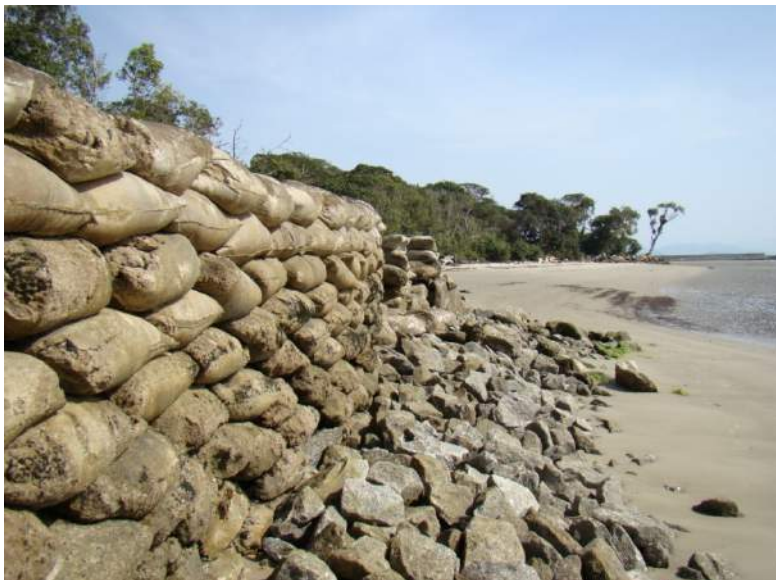
FIGURA 36: OBRA DE CONTENÇÃO MISTA CONSTITUÍDA DE ROCHAS E SACOS PREENCHIDOS COM CIMENTO PRÓXIMO AO PERFIL 3
