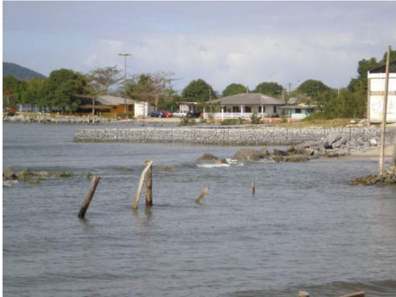
FIGURA 37: MURO DE GABIÕES PRÓXIMO AO CANAL DO DNOS
