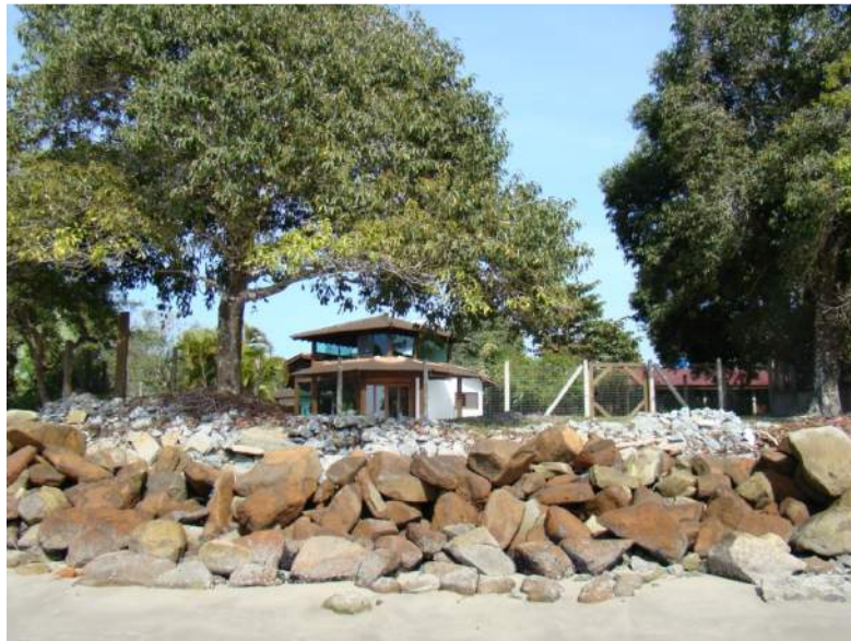
FIGURA 34: ENROCAMENTO DE ROCHAS CONSTRUÍDO EM FRENTE À CASA DE ALTO PADRÃO
