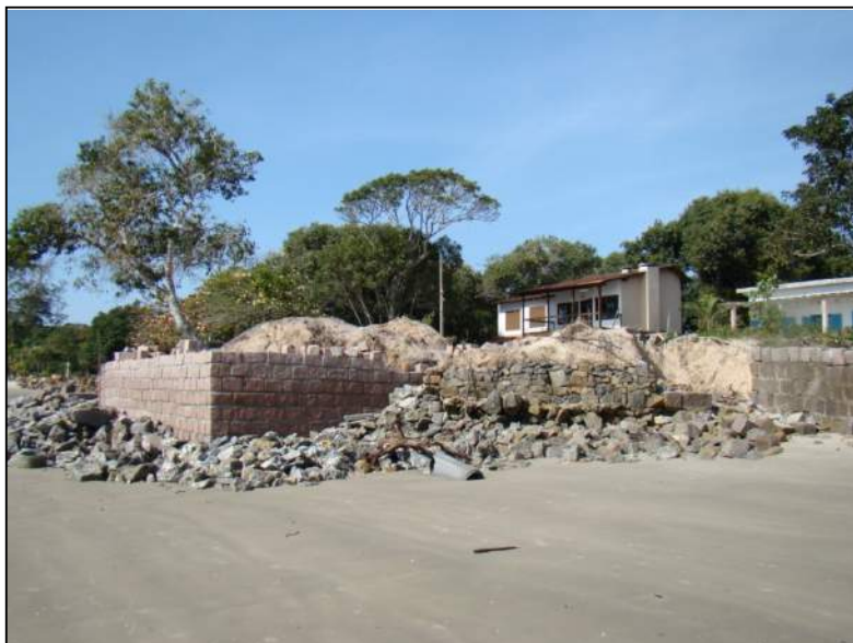
FIGURA 38: OBRA EM CONSTRUÇÃO QUE DARIA ORIGEM A UM PÍER
