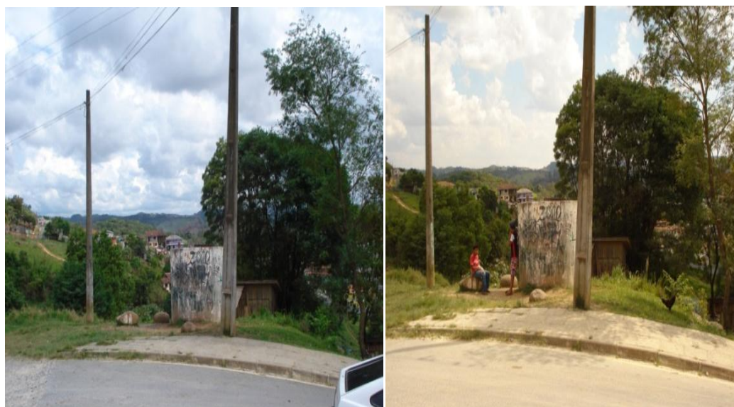
FIGURAS 40 E 41 – RESERVATÓRIOS DE ÁGUA EM DIFERENTES PONTOS EM RIO BRANCO DO SUL FONTE: Silva, M. C. B (pesquisa de campo)
