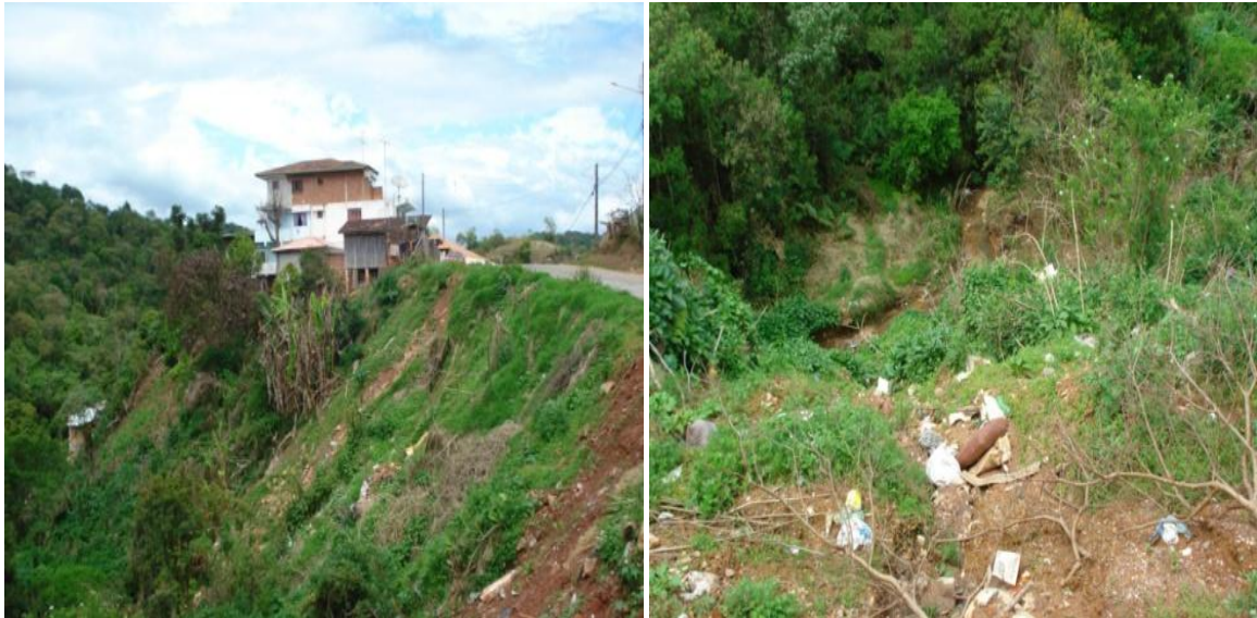
FIGURAS 58 E 59– RESÍDUOS DISPOSTOS DE FORMA INADEQUADA Fonte: SILVA, M. C. B (pesquisa de campo)
