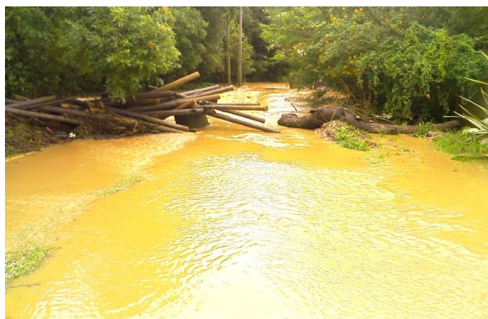
FIGURAS 49 E 50 – PONTE SOBRE RIO CAPIVARI/ COLOMBO LEVADA PELA ENCHENTE FONTE: SILVA, M. C. B (pesquisa de campo).
