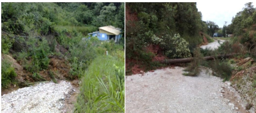
FIGURAS 44 e 45 - ESTRADAS BLOQUEADAS POR DESLIZAMENTOS - COLOMBO FONTE: SILVA, M. C. B (pesquisa de campo)
