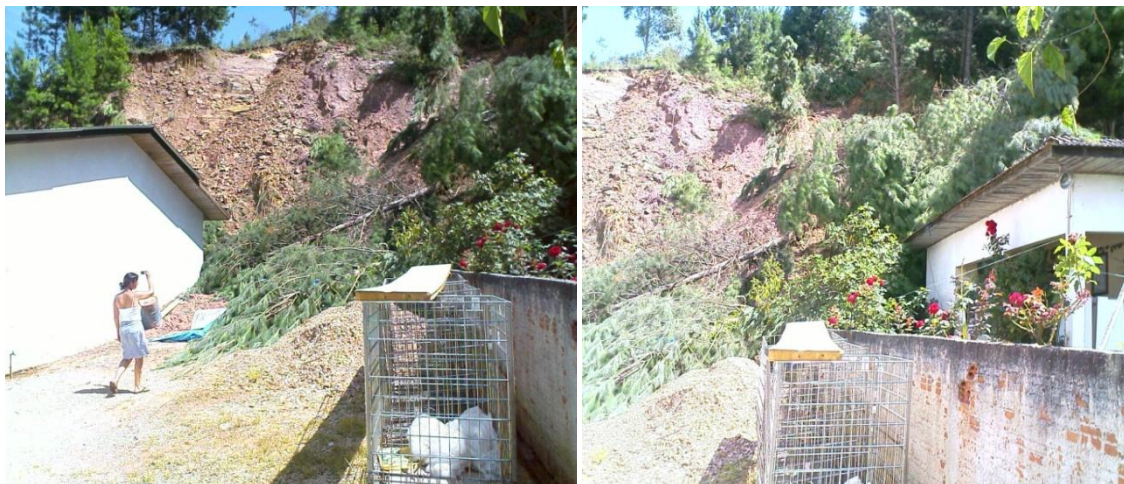
FIGURAS 51 E 52 - CASAS ATINGIDAS POR DESLIZAMENTO – BOCAIÚVA DO SUL FONTE: SILVA, M. C. B (pesquisa de campo)
