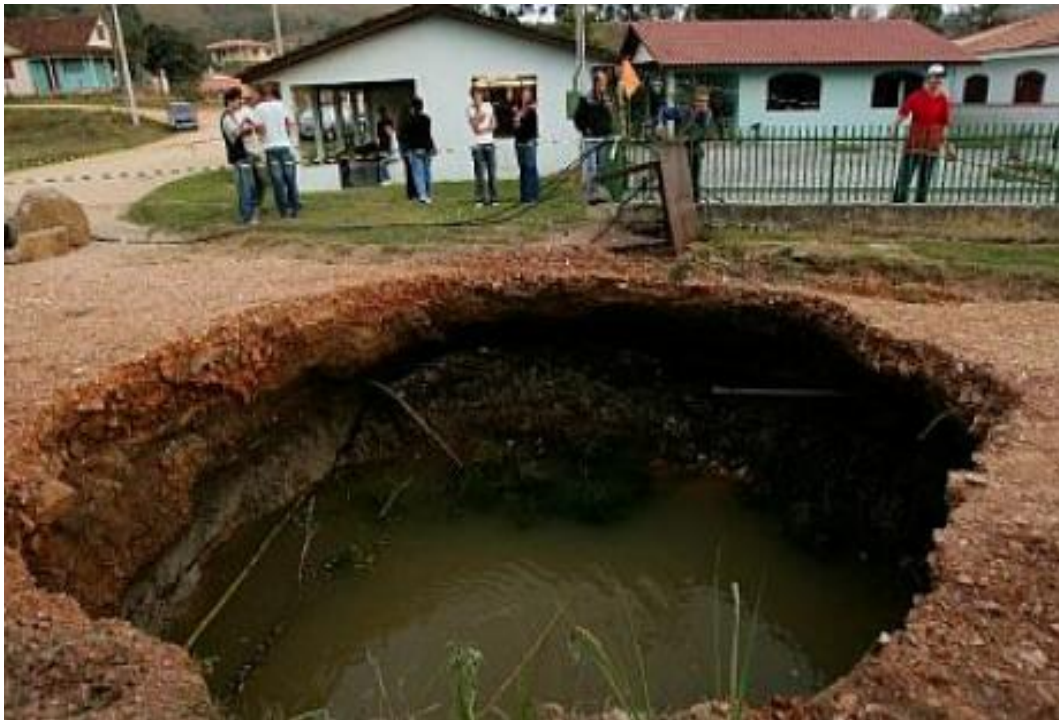
FIGURA 75 – DOLINA DE ABATIMENTO EM PLANÍCIE CÁRSTICA EM BOCAÍUVA - Rua Gilmar Ceccon, (Campininha do Capivari- Bocaiúva do Sul).
