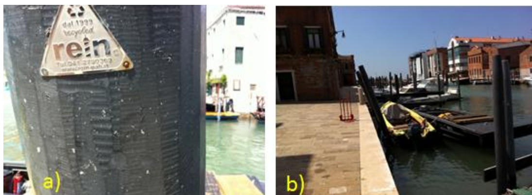
FIGURA 2.2 - UTILIZAÇÃO DE ESTACAS DE PLÁSTICO COMO DEFENSAS (VENEZA - ITÁLIA, 2012). FONTE: DO AUTOR (2012)
