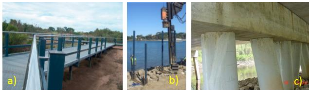
FIGURA 2.1 - (a) e (b) CRAVAÇÃO DE ESTACAS FRP – (AUSTRÁLIA). (c) ESTACAS ARMADAS COM PROTEÇÃO EXTERNA DE PVC – (EUA) FONTE: GUADES (2012) E PANDO (2006)
