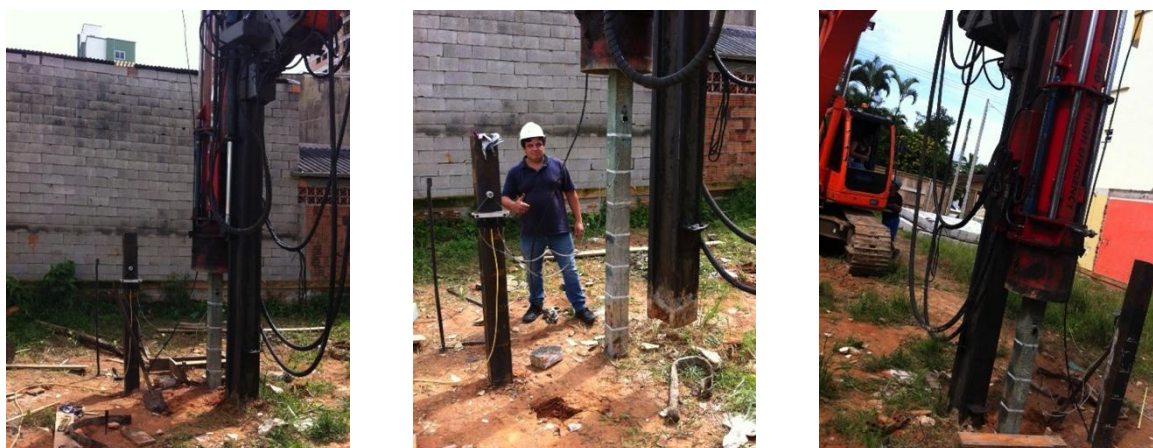
FIGURA 3.27 - CRAVAÇÃO DO PROTÓTIPO UTILIZANDO MARTELO HIDRÁULICO FONTE: DO AUTOR
