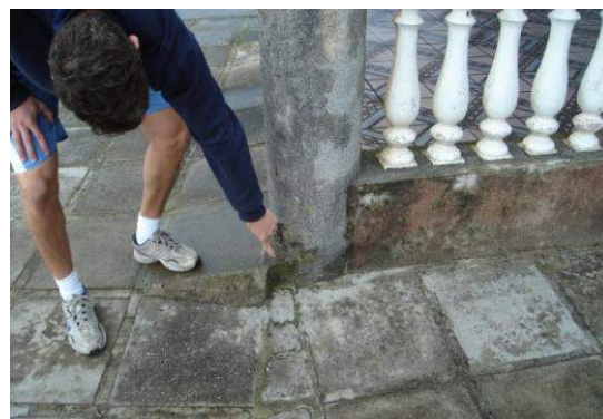
FIGURA 14 – LOCAL DE APOIO DA MIRA, ATRÁS DE PEQUENO DEGRAU
