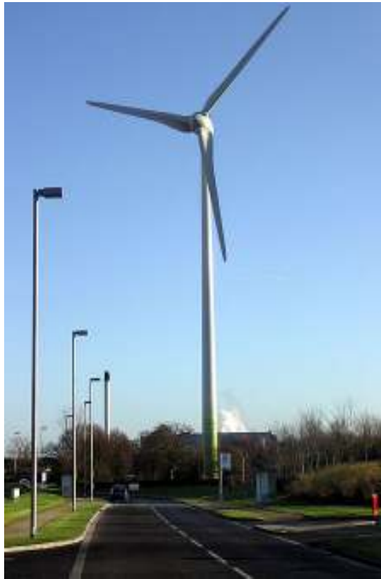
FIGURA 9 – ROTOR TIPO HÉLICE COM ROTOR A BARLAVENTO DA TORRE.
