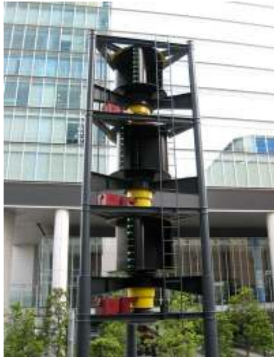
FIGURA 7 – AEROGERADOR TIPO SAVONIUS.
