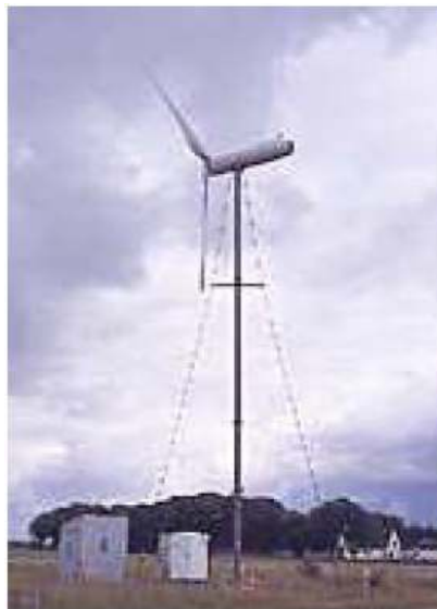
FIGURA 10 – ROTOR TIPO HÉLICE COM ROTOR A SOTAVENTO DA TORRE.
