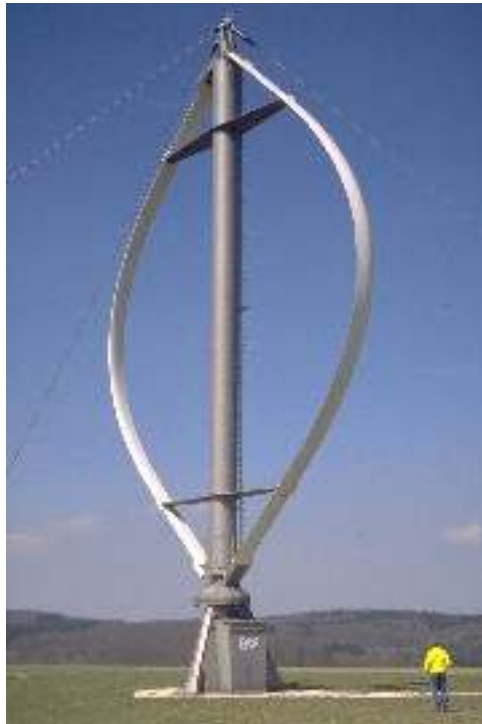
FIGURA 6 – AEROGERADOR TIPO DARRIEUS.
