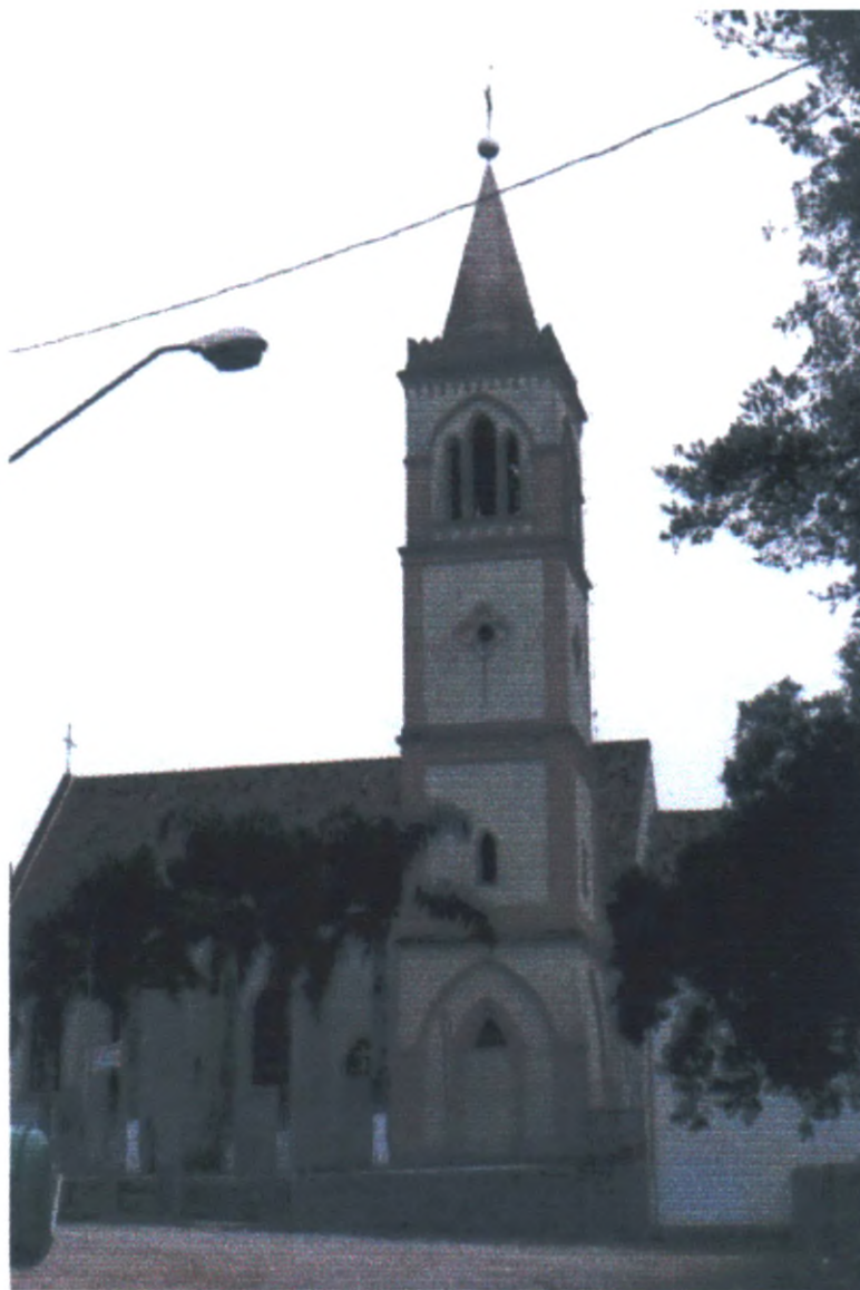
Igreja Nossa Senhora da Saúde (Colônia Faria). Vista lateral direita. Observar a torre como construção independente. À direita encontra-se o bosque da igreja (não visível na foto).
