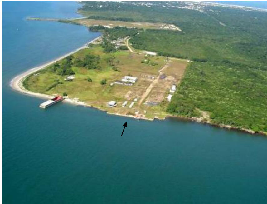
Figura 2. Local de instalação das estruturas experimentais
