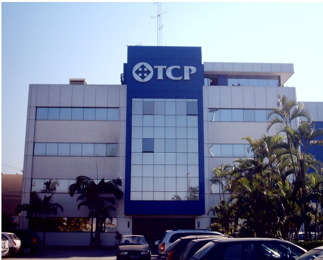
FIGURA 8. PRÉDIO DA ADMINISTRAÇÃO DO TCP
