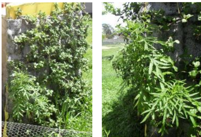
Figura 63 - Planta invasora na fachada Leste. À direita, detalhe da planta. Fonte: O autor, 2013.
