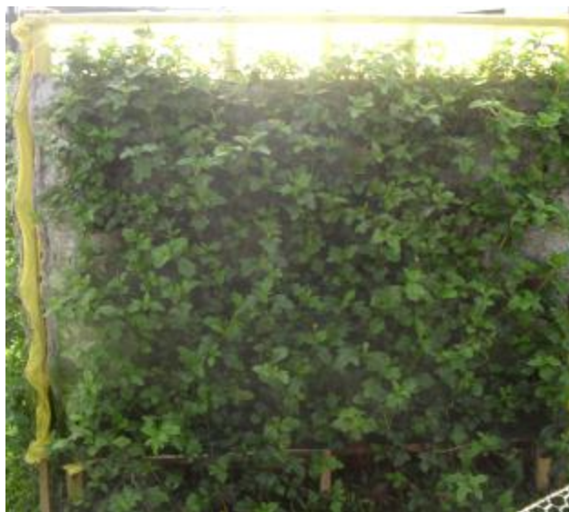
Figura 58 – Vista frontal da fachada viva voltada ao Sul. Fonte: O autor, 2013.
