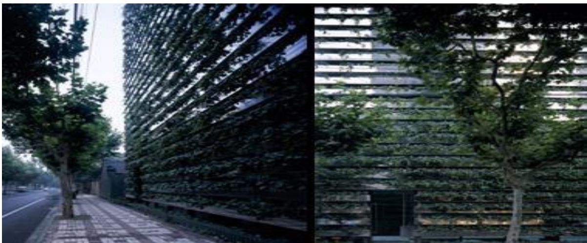
Figura 18 – Vista em perspectiva e frontal do Edifício Z58. Fonte: UFFELEN, 2011.
