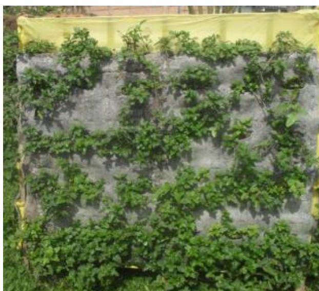
Figura 61 – Vista frontal da fachada viva voltada ao Norte. Fonte: O autor, 2013.
