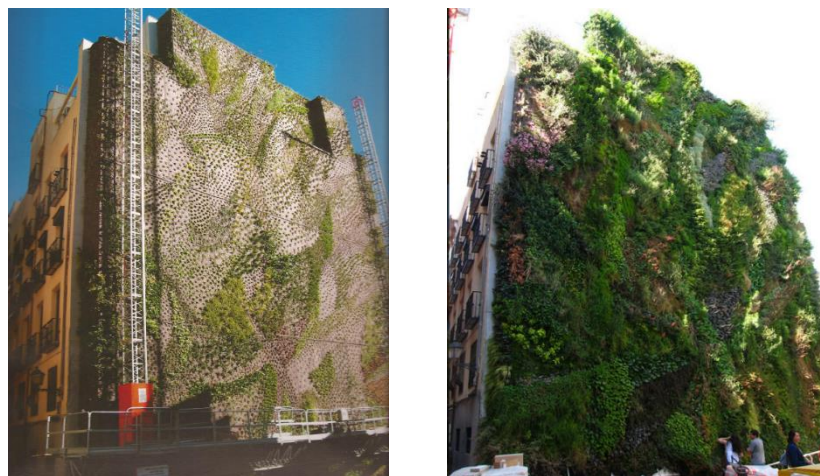
Figura 20 - Caixa Fórum Museum. À esquerda, em construção, e à direita, finalizado. Fonte: BLANC, 2011.
