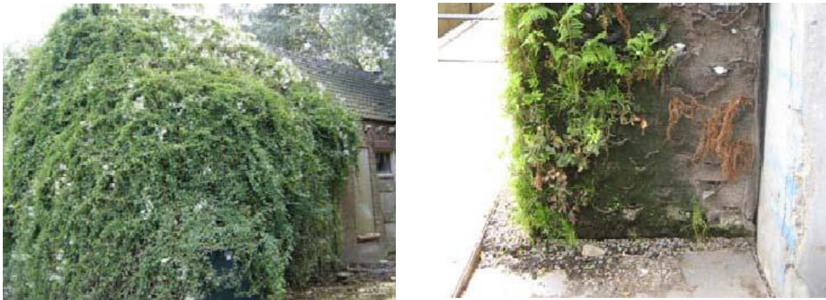
Figura 15 – Problemas ocasionados pela falta de manutenção: À esquerda, perda do controle da fachada verde sobre o edifício e à direita, má formação das plantas na fachada viva. Fonte: IRWIN et. al. , 2010.
