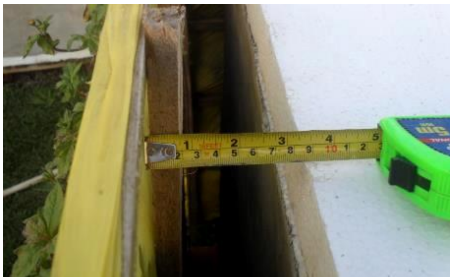
Figura 42- Espaçamento da cavidade (9cm). Fonte: O autor, 2013.
