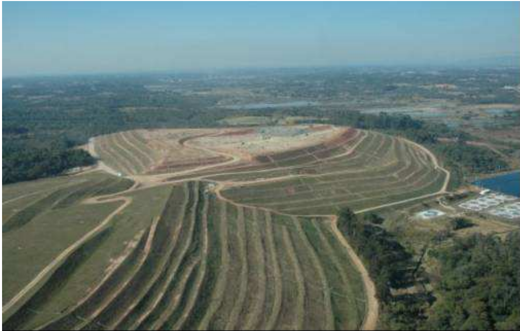
FOTOGRAFIA 1 – VISTA GERAL DO ATERRO SANITÁRIO DA CAXIMBA FONTE: ADECOM (2010)
