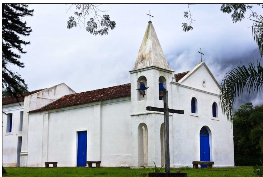
FIGURA 3 – IGREJA SÃO SEBASTIÃO DE PORTO DE CIMA FOTO: ROSANE PIKUSSA, 2014.
