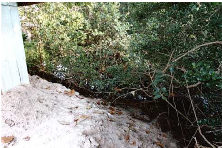
Foto 3 – Aterramento em área limítrofe ao Rio Perequê.
