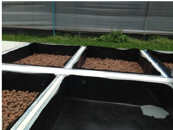
Figura 25 - Manta geotêxtil por cima da abertura de escoamento
