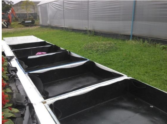
Figura 24 - Mantas PEAD colocadas
