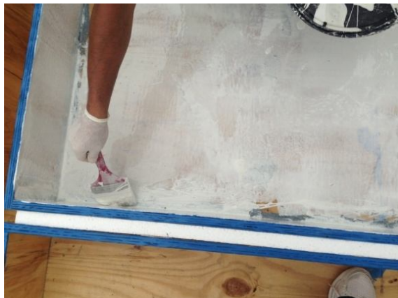
Figura 22 - Impermeabilizante nas laterais e fundos
