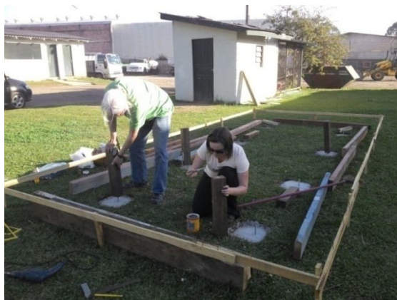
Figura 15 - Colocação dos pilares de madeira nas esperas das sapatas.
