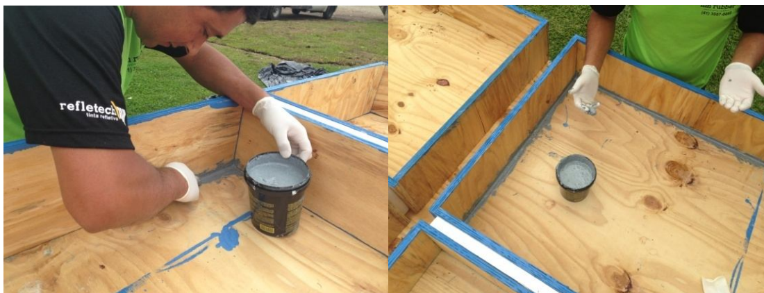
Figura 20 – Colocação do impermeabilizante nas frestas
