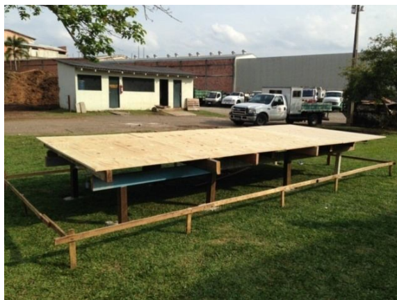
Figura 17 - Chapa colocada para receber os módulos
