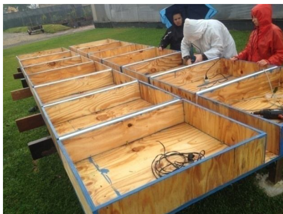
Figura 88 - Módulos sendo aparafusados
