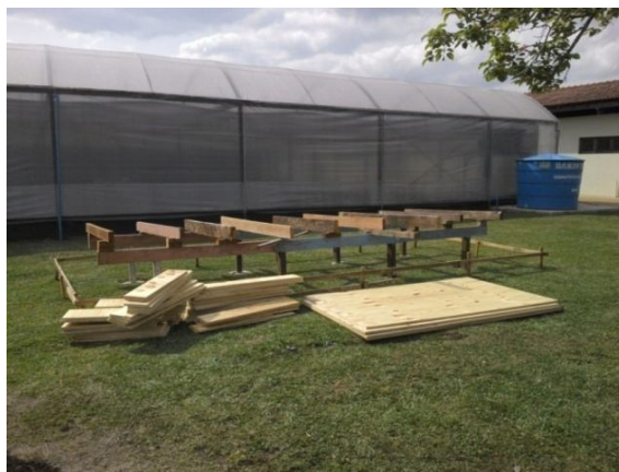
Figura 16 - Estrutura pronta e chapas de compensado naval para os módulos
