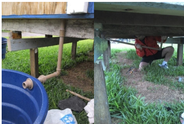
Figura 29 9-Colocação dos tubos de 32 mm e das caixas de água
