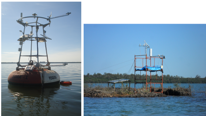
Figura 4.11: Sistema de medição de temperatura da água acoplado na boia SIMA I, à esquerda, e a estação micrometeorológica quando sua base coincide com o nível do reservatório, à direita.
