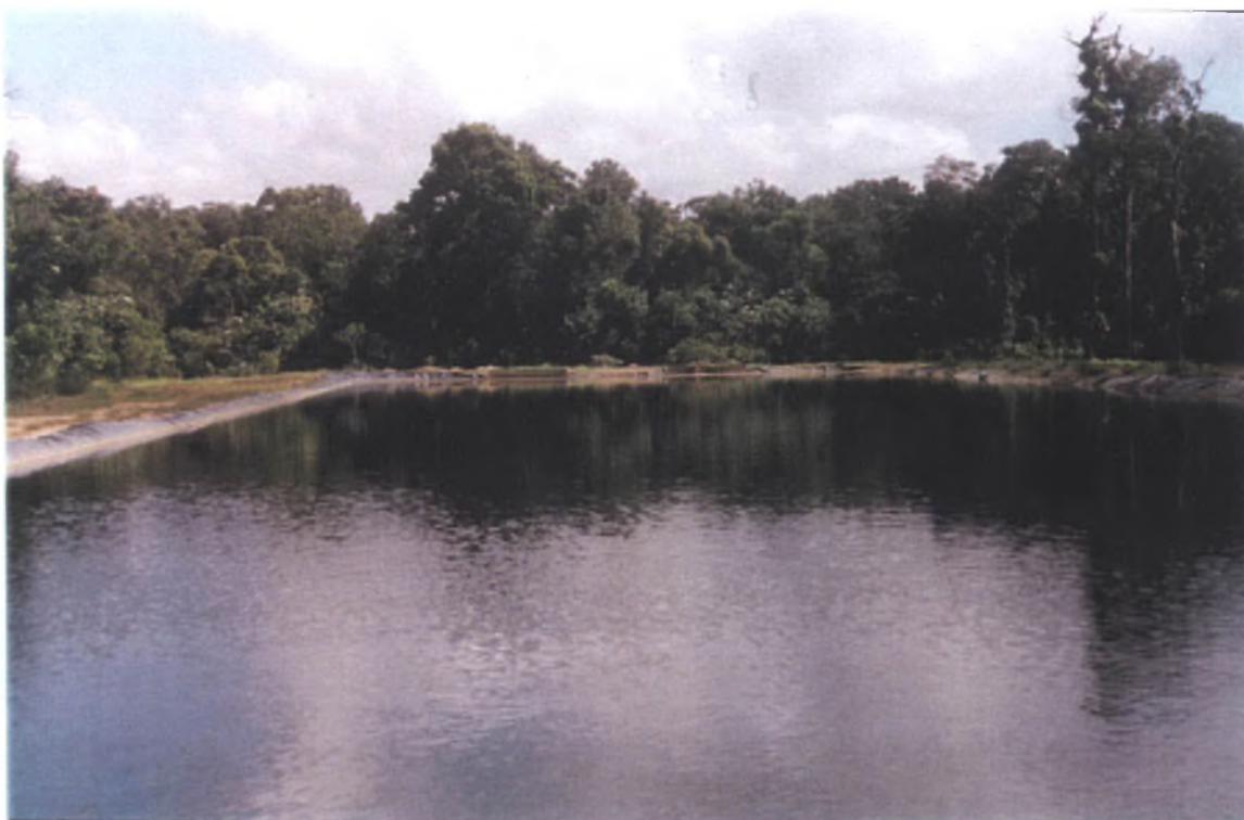
FOTO 3 – Bacia anaeróbica/sistema de tratamento de efluentes (CIAS) – 17/04/02
