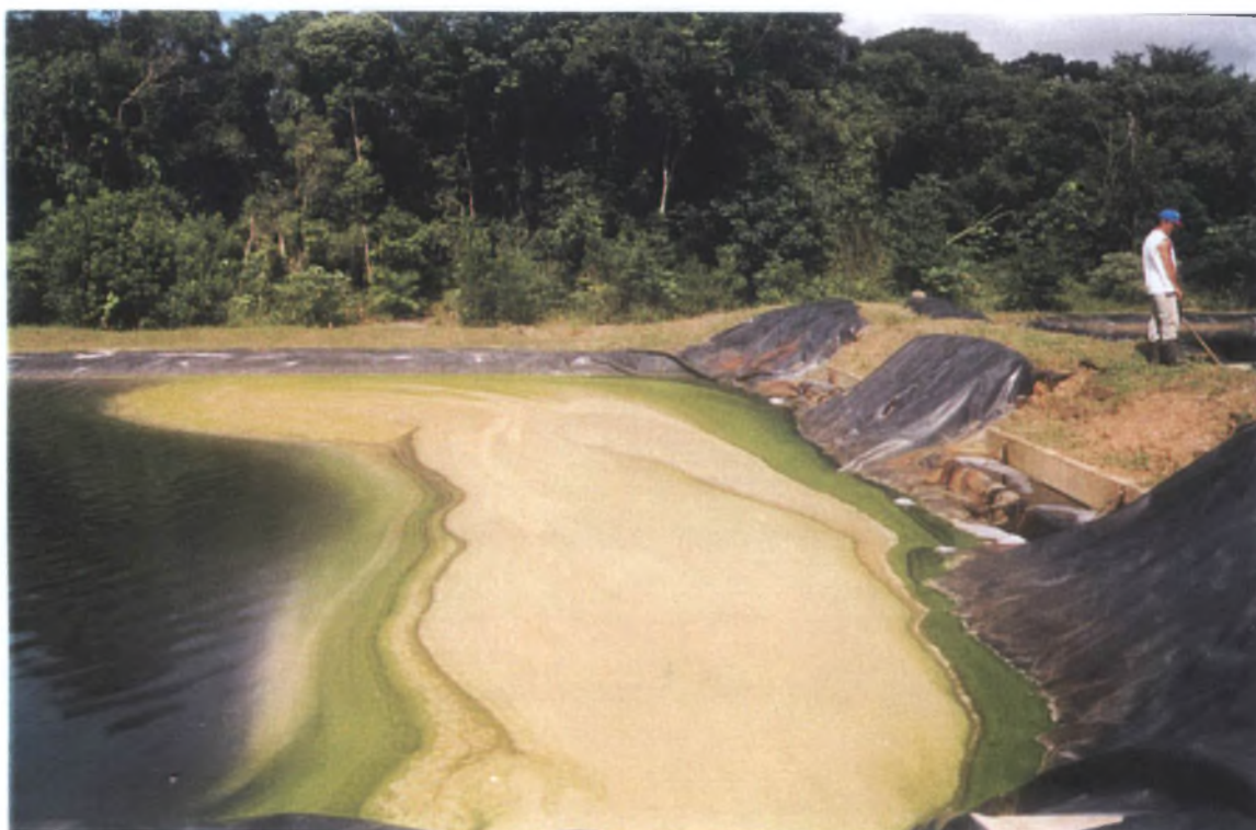
FOTO 4 – Bacia facultativa/sistema de tratamento de efluentes (CIAS) – 17/04/02.
