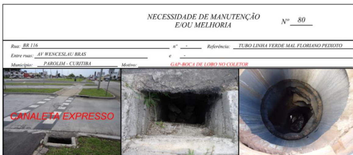
Figura 78 - Lançamento do sistema de drenagem no sistema coletor de esgoto. FONTE: SANEPAR USEG (2013)
