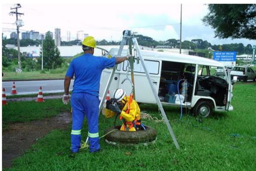
Figura 35 - Foto da descida do operador para a instalação do medidor de vazão. Fonte: SANEPAR (2012)
