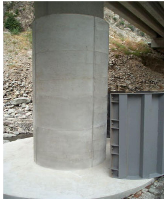
Figura 7. Reparo nos blocos de fundação e pilares de um viaduto em Valabres – França.
