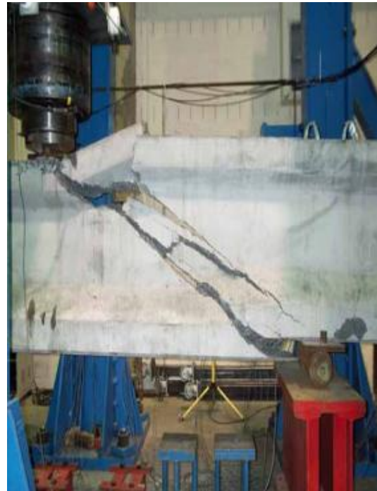
Figura 25. Imagem da ruptura de uma viga de CUAR após prova de carga.
