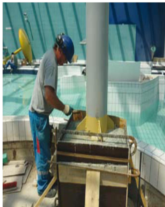
Figura 12. Proteção em CUAR para a base de pilares metálicos – França.
