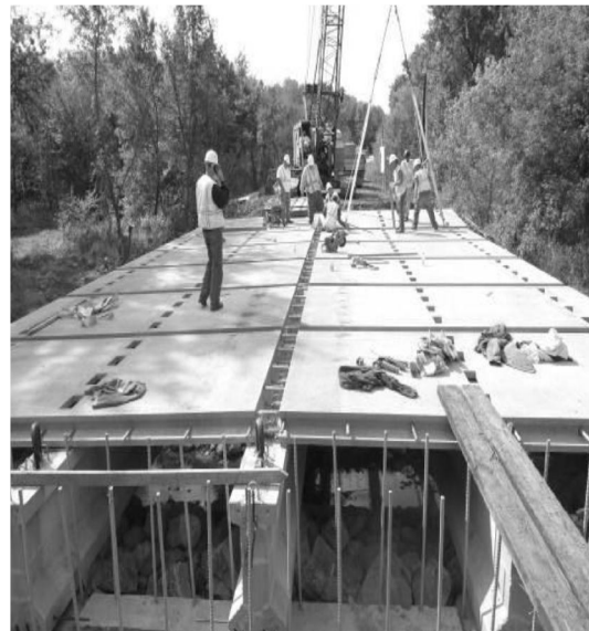
Figura 3. Construção de ponte rodoviária em CUAR – Estados Unidos.
