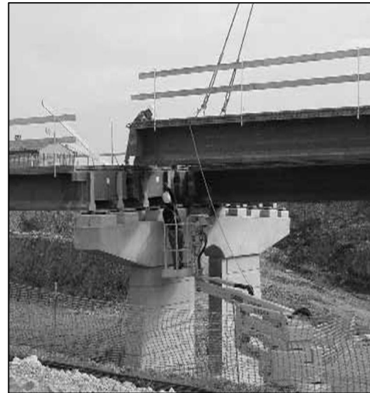
Figura 18. Construção da primeira ponte rodoviária da França em CUAR.
