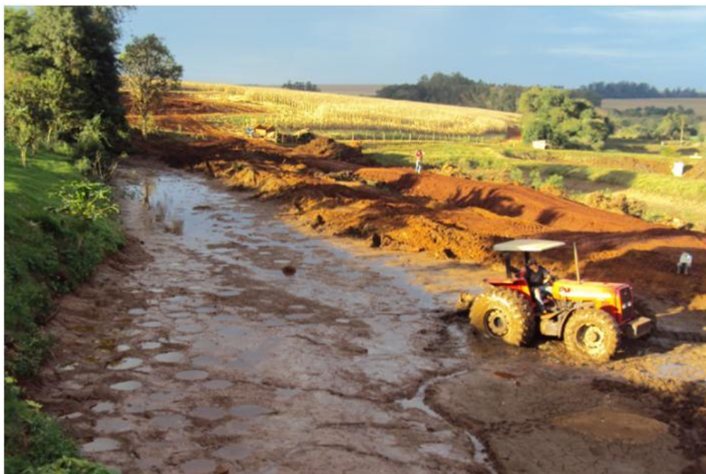
FIGURA 5 – Retirada do lodo dos tanques de cultivo. Arquivo pessoal.
