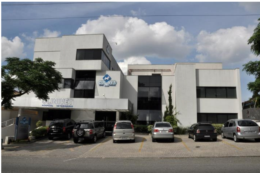
Figura 1 - Fachada da Clinivet - Hospital e Centro de Diagnóstico Veterinário - Curitiba 2013. Fonte: http://www.clinivet.com.br
