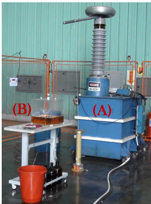
Figura 18: Arranjo de ensaio da tensão de ruptura dielétrica, em (A) transformador da marca Biddle e em (B) cuba de acrílico.
