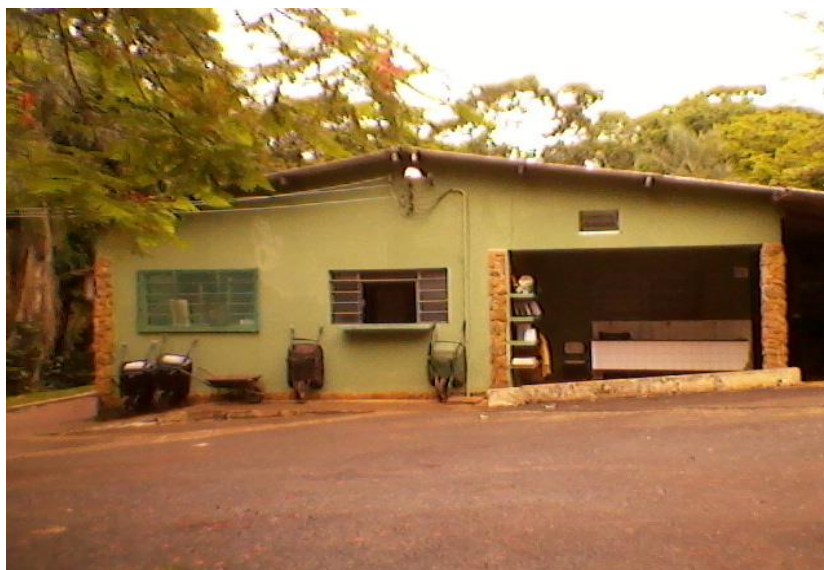
FIGURA 14 - Cozinha do PEMA (lado externo)
