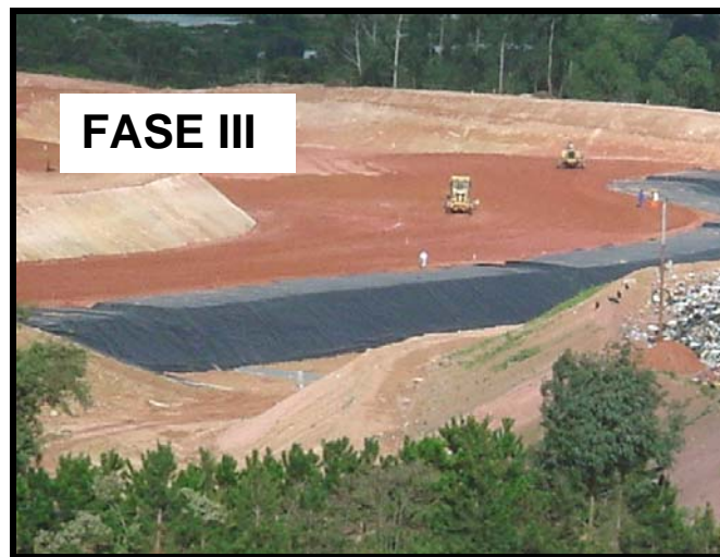
Figura 4. Visão parcial do Aterro da Caximba onde pode ser observada a Fase III em construção (Fotografado em 28 de abril de 2004).
