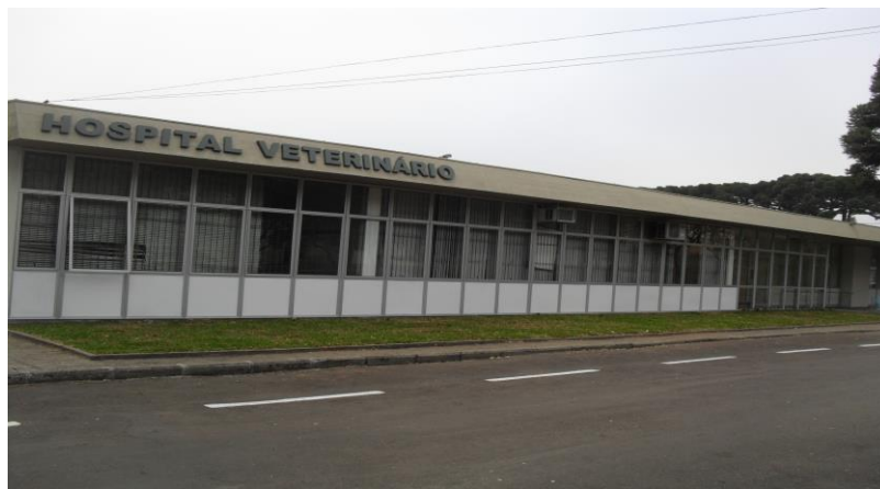
Figura 1 - Vista frontal do Hospital Veterinário da UFPR, Campus Agrárias , onde foi realizado o estágio supervisionado, no período de 12 de agosto a 27 de setembro de 2013. (FONTE: Arquivo pessoal).
