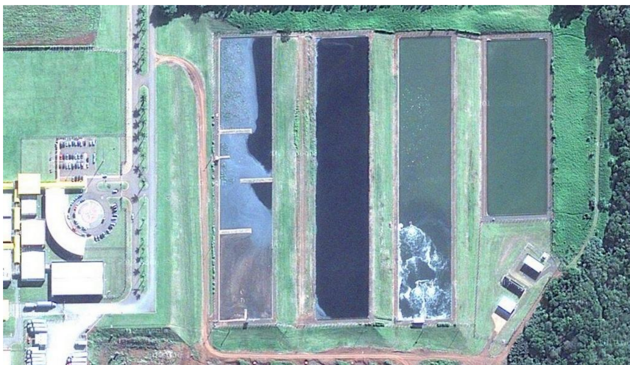
FIGURA 7: Imagem aérea das lagoas de tratamento
