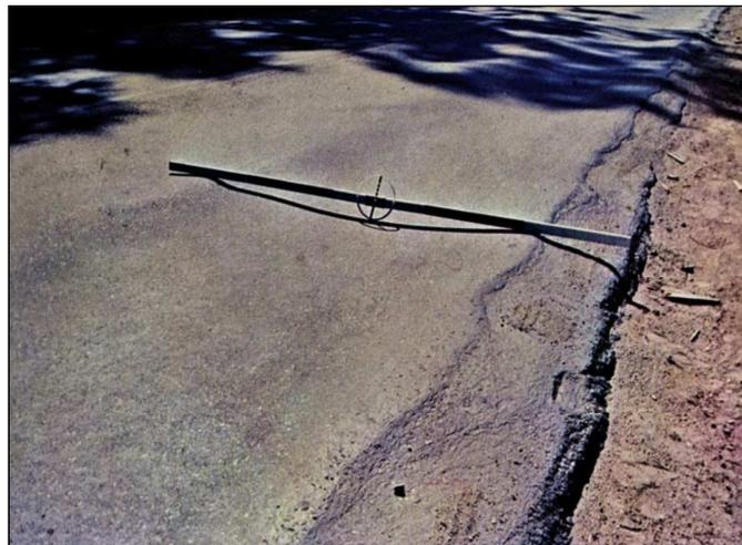
FIGURA 13: AFUNDAMENTO TRILHA DE RODA (FONTE: DNIT 005/2003-TR).
