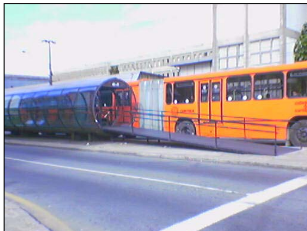
Foto 6 – Detalhe da rampa de acesso à estação tubo
