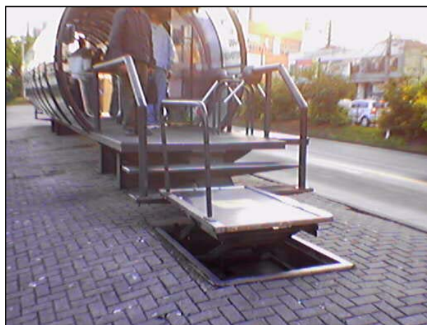
Foto 4 – Detalhe de elevador em estação tubo
