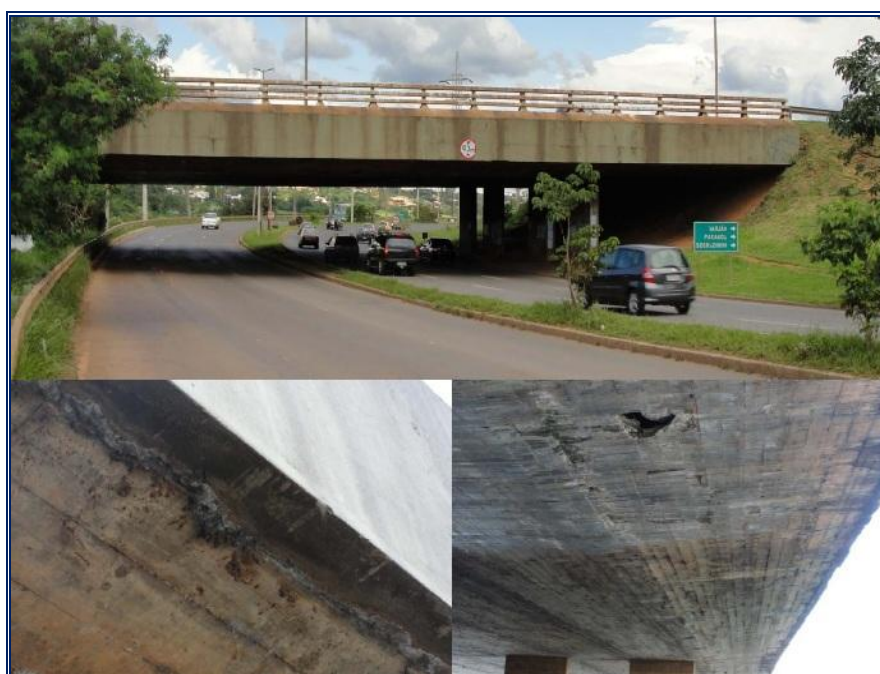
FIGURA 5 - PONTE DO BRAGUETO - DISTRITO FEDERAL.
