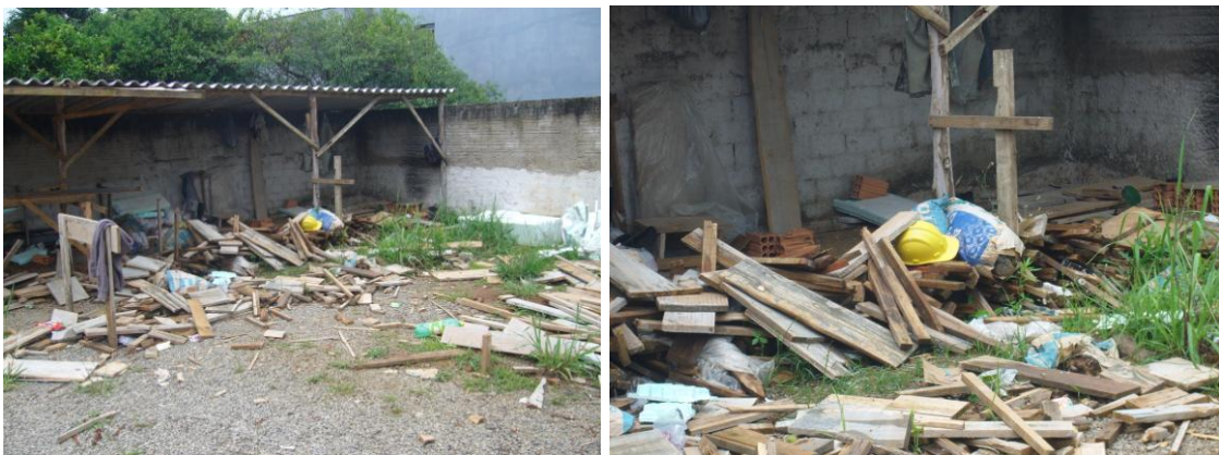
Figura 9 e 10- Canteiro de obra com presença de entulho, o que prejudica a circulação no ambiente e a organização, possibilitando ainda a presença de animais peçonhentos. Também o descuido com o equipamento de proteção, no caso o capacete.
