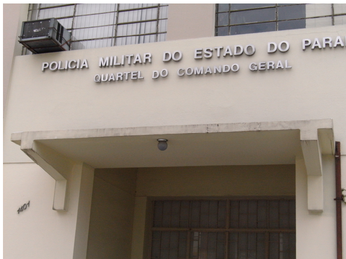
Figura 29: Execução da intervenção corretiva na marquise do Quartel da PMPR Fonte: Registro fotográfico.
