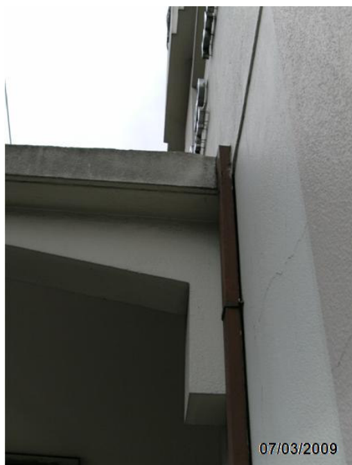
Figura 25: Consolo lado direito – parte externa, sem presença de fissuras. Fonte: Registro fotográfico.
