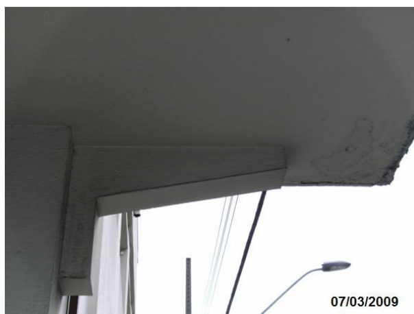
Figura 26: Consolo lado direito – parte interna, sem presença de fissuras. Fonte: Registro fotográfico.
