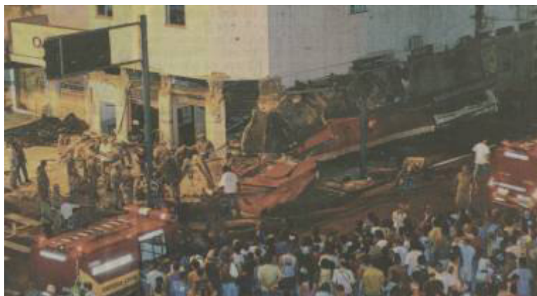
Figura 2: Desabamento de marquise em 24/03/06 na Vila Isabel-SP. Fonte: Rizzo (2007).
