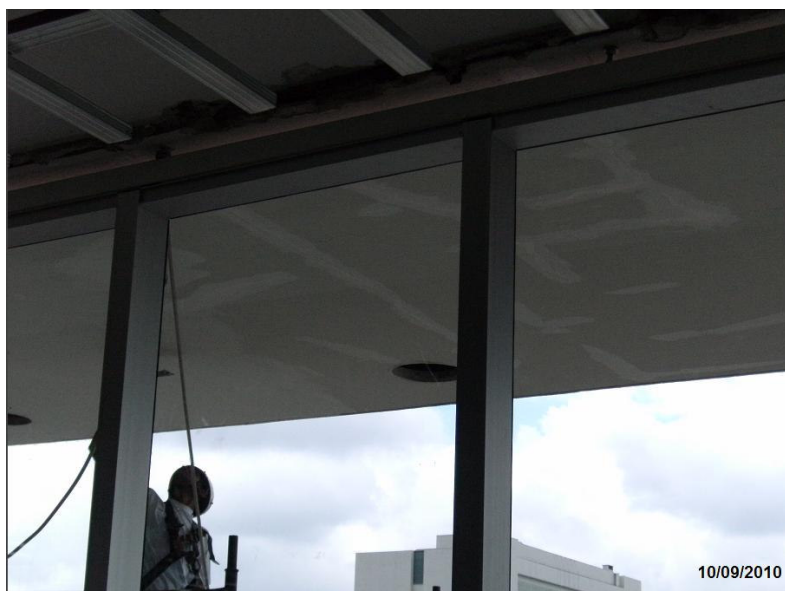
Figura 41: Emassamento das fissuras e trincas.
