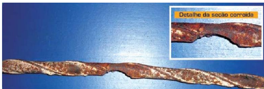
Figura 9: Armadura corroída e com perda de seção de aço.
