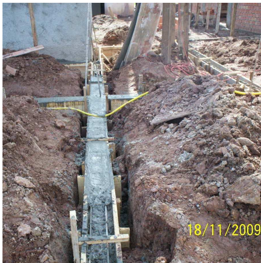
Figura 20 – Concretagem de viga de baldrame em obra do Hospital Wallace Thadeu de Mello e Silva em Guaraqueçaba-PR.
