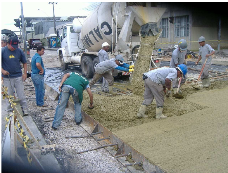
Figura 04 – Concretagem da Avenida Marechal Floriano Peixoto, tendo o devido acompanhamento da fiscalização da Secretaria Municipal de Obras Públicas de Curitiba. 2009.
