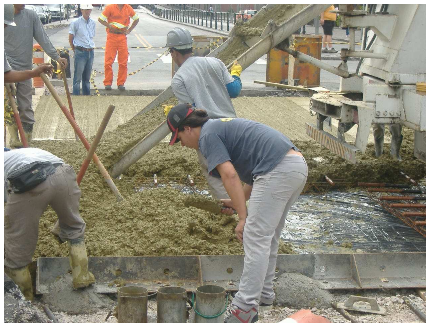
Figura 11 – Concretagem da Avenida Marechal Floriano Peixoto. Acompanhamento com a fiscalização da Secretaria Municipal de Obras Públicas de Curitiba.
