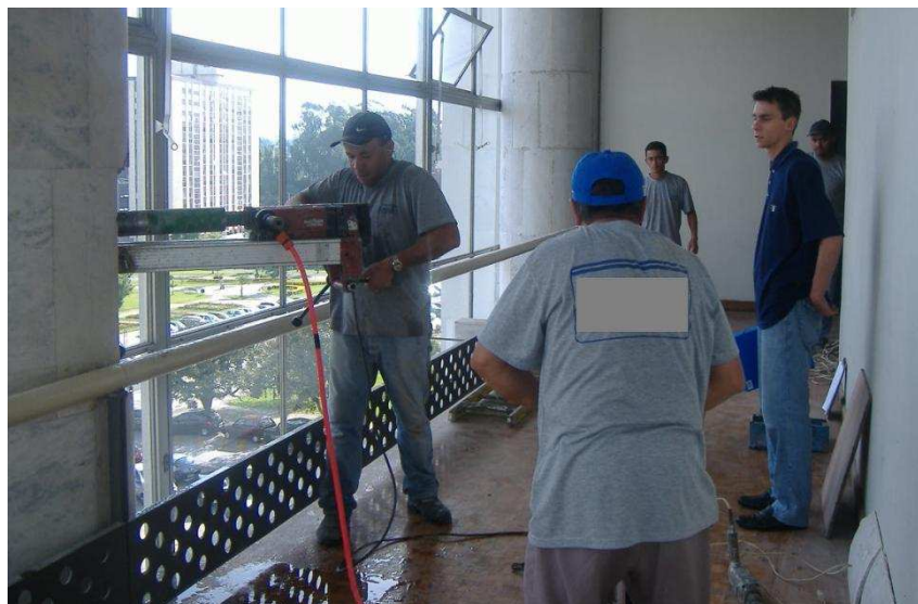
Figura 18 – Realizações de ensaios tecnológicos do concreto no Palácio Iguazu. Curitiba-PR.
