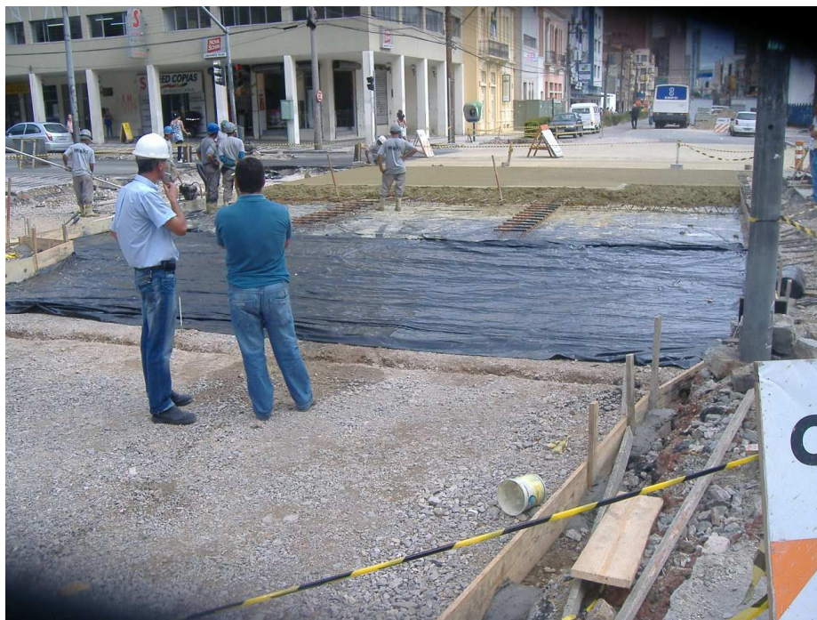
Figura 12 – Imagem do fiscal de obras da Secretaria de obras de Curitiba em conversa com o responsável técnico da empresa contratada.
