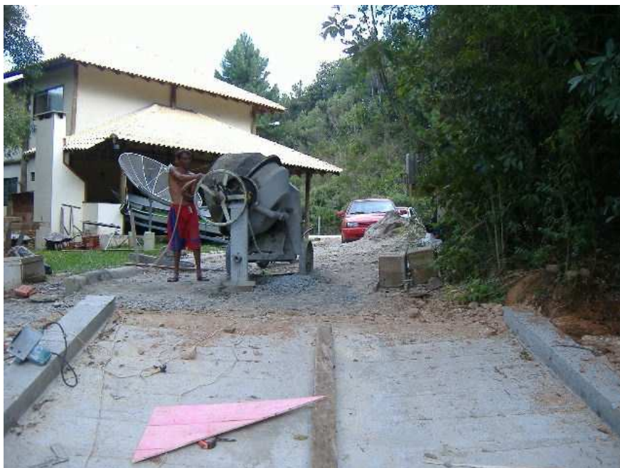
Figura 16 – Concretagem de rampa de concreto armado para acesso aos barcos da Polícia Ambiental de Tijucas do Sul - PR.
