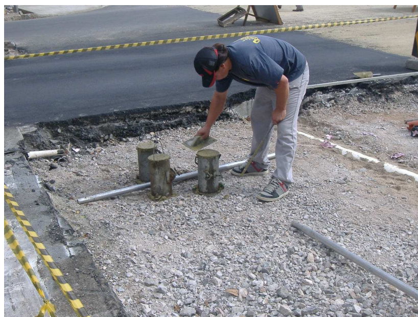
Figura 13 – Adensamento e acabamento dos corpos-de-prova recolhidos para ensaios de controle, feito pelo operário responsável para tal tarefa.
