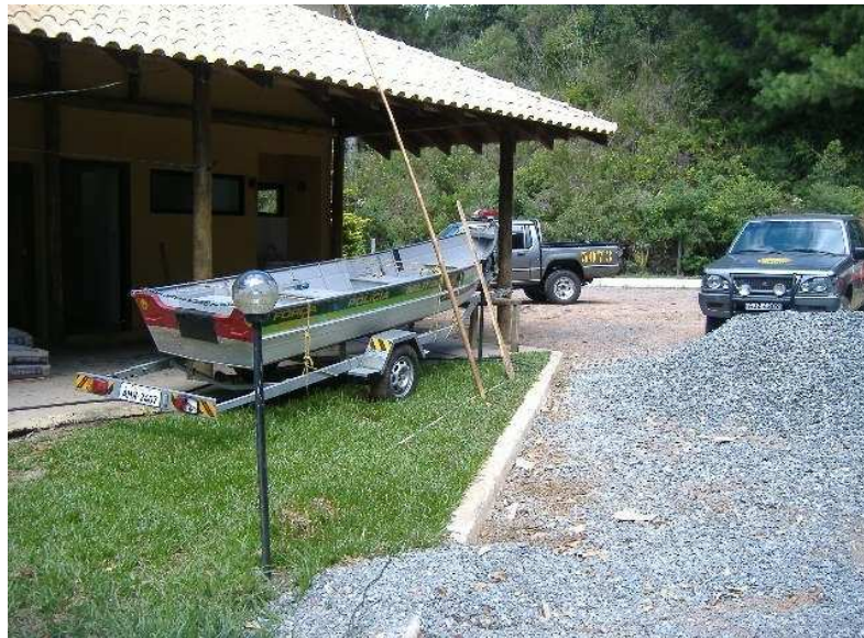
Figura 08 – Armazenamento incorreto de agregados graúdos em uma obra Pública localizada em Tijucas do Sul –PR.
