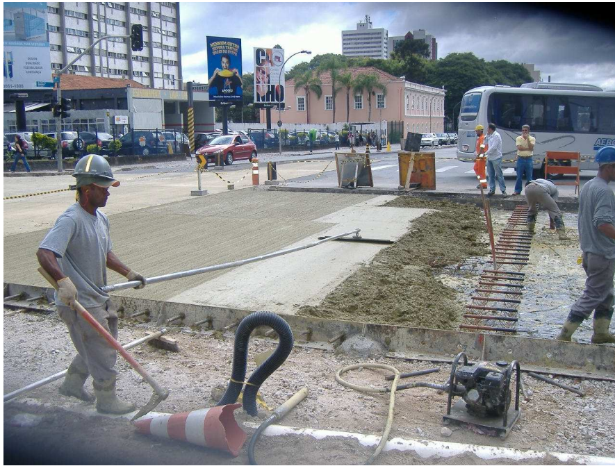
Figura 14 – Concretagem, adensamento com vibrador de imersão e acabamento do concreto na Avenida Marechal Floriano Peixoto esquina com Avenida Sete de Setembro – Curitiba – PR.
