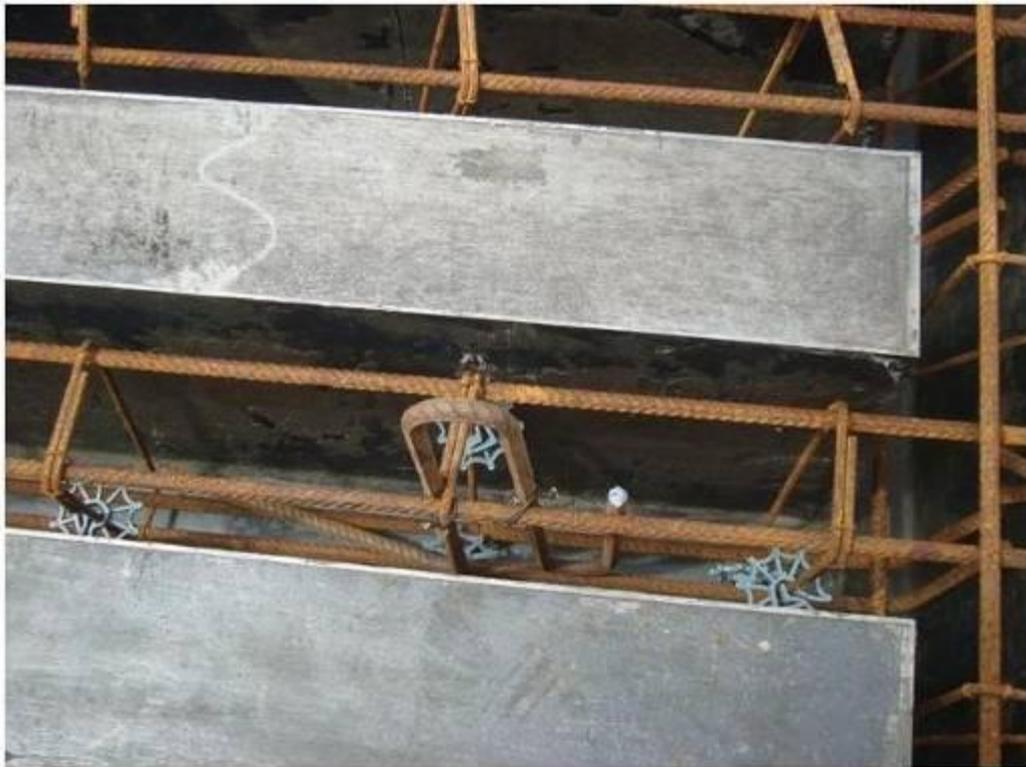
Foto 8.2 – Içador amarrado na armação do Brise
