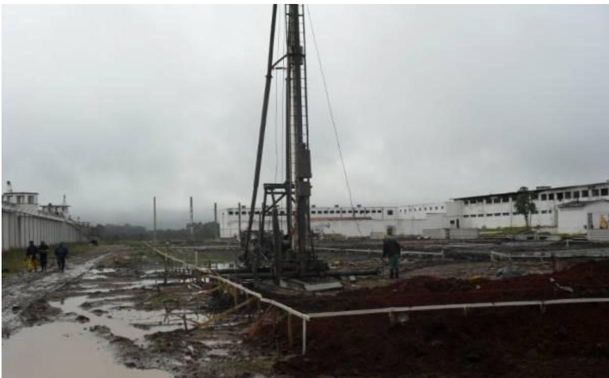
**Foto 14.2 – Serviço de Bate-estaca sendo executado**
