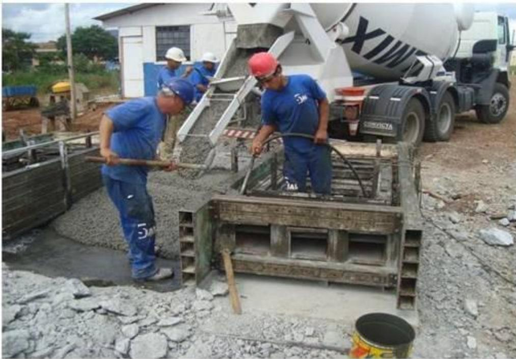
**Foto 5.7 – Bancada sendo concretada e vibrada**
