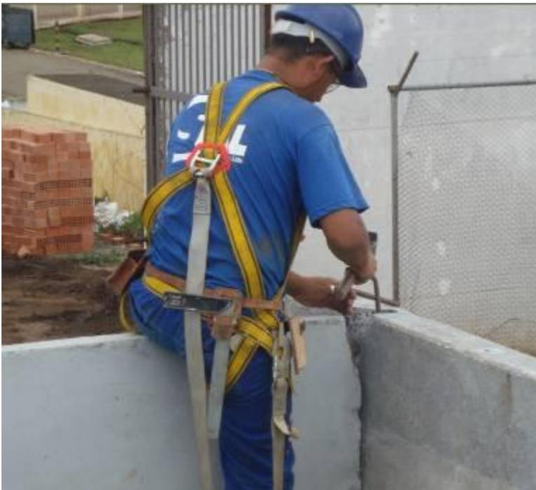
**Foto 19.2 – Fixação da peça “U” nas Placas**
