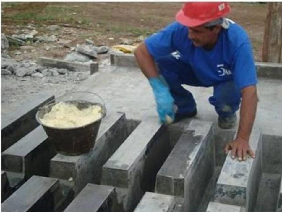
**Foto 12.1: Utilização da Cera desmoldante na forma dos Brises**
