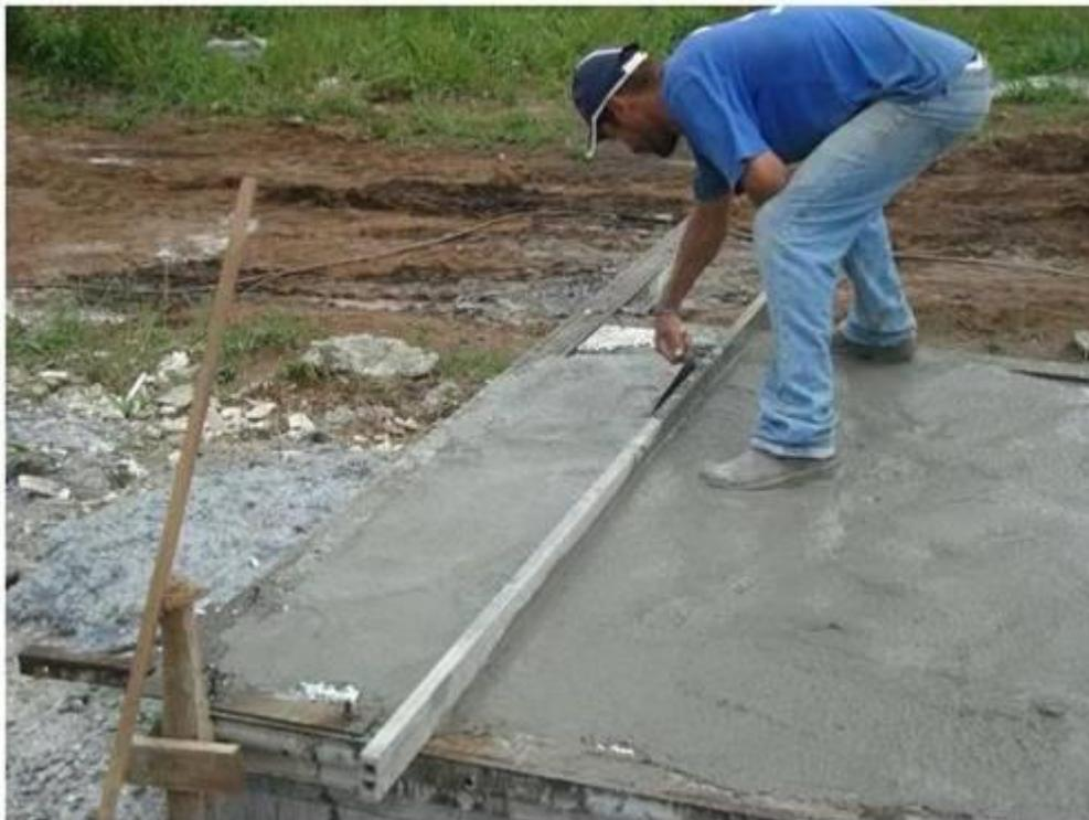
**Foto 5.4 – Laje de Couro Duro sendo adicionado o Agregado já preparado**
