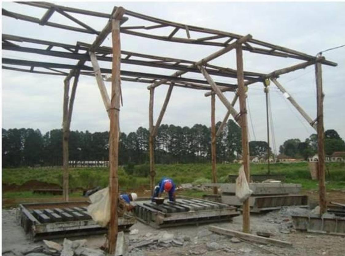
**Foto 5.5 – Local de concretagem dos Brises**
