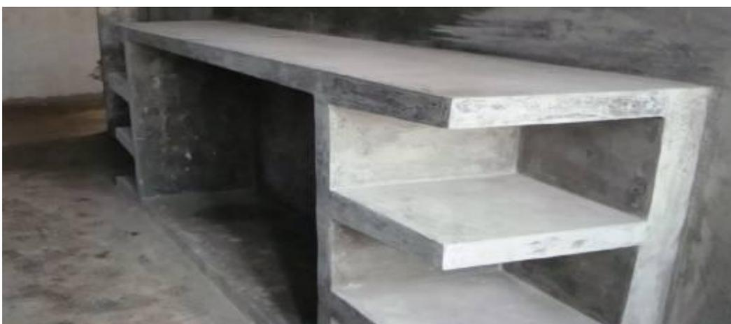
**Foto 20.5 – Bancada já fixada com argamassa de alta resistência**
