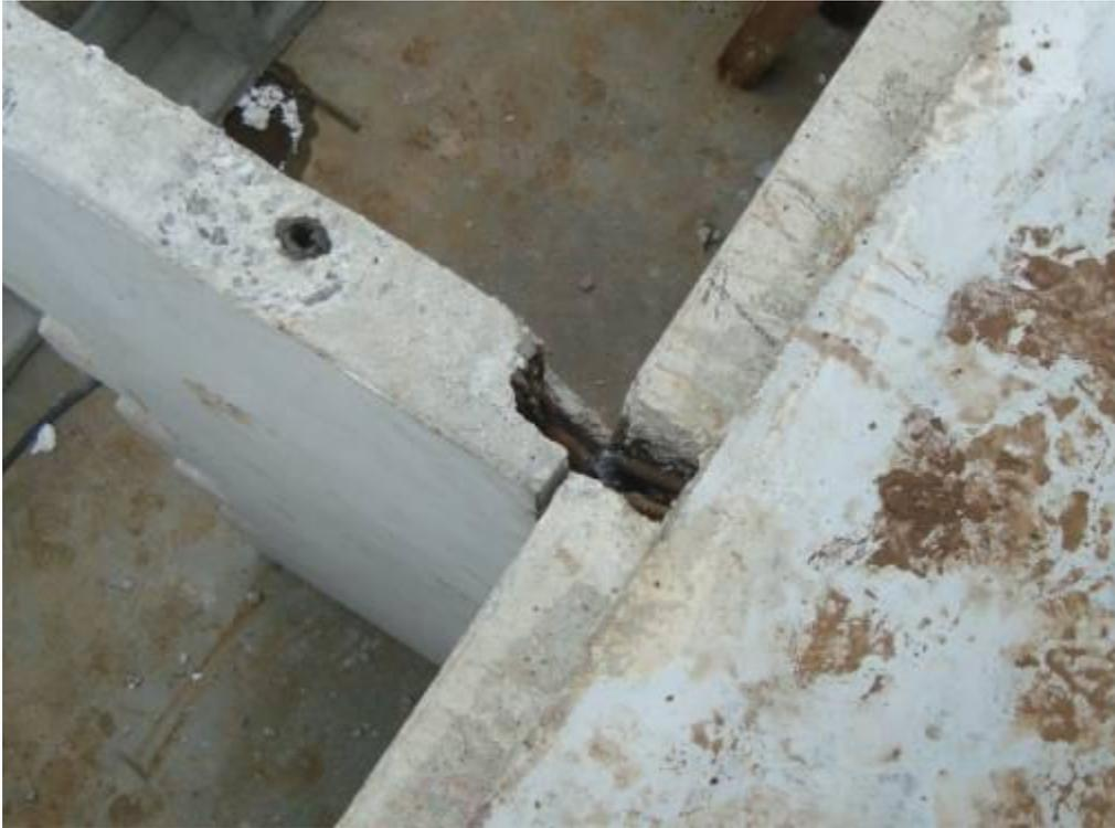
**Foto 19.3 – Peça “U” já soldada nas Placas com a laje**
