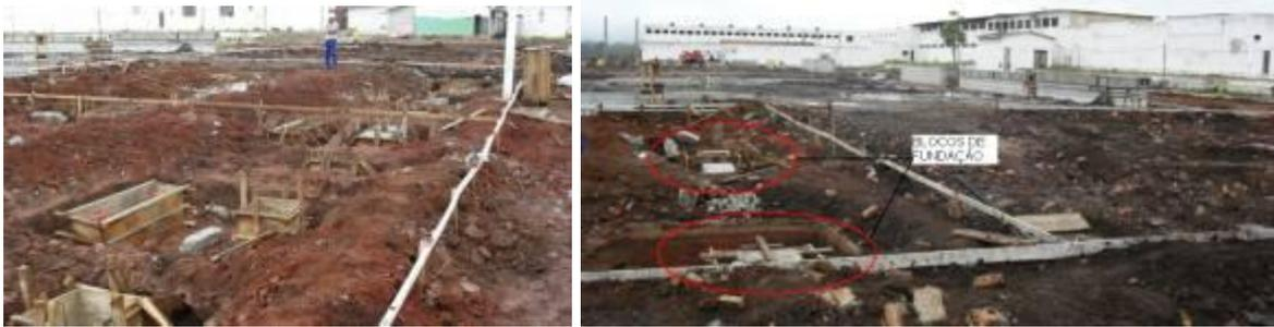
**Fotos 14.3 – Local dos Blocos de Fundação e Gabarito da Construção**
