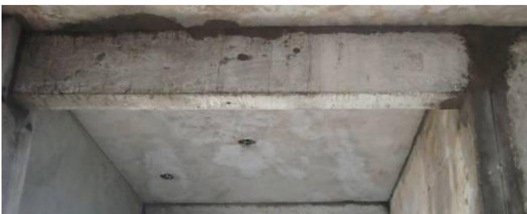
**Foto 20.4 – vigas e placas com argamassa de vedação e acabamento**
