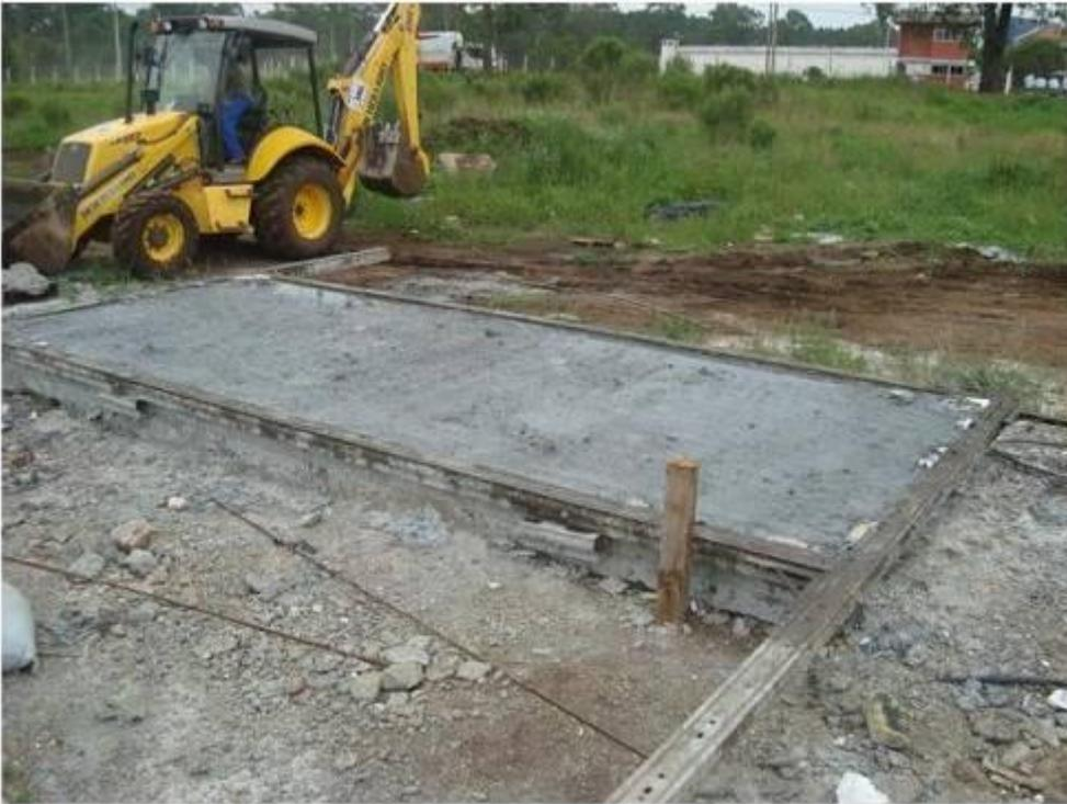
**Foto 5.3 – Laje de Couro Duro sem o agregado**
