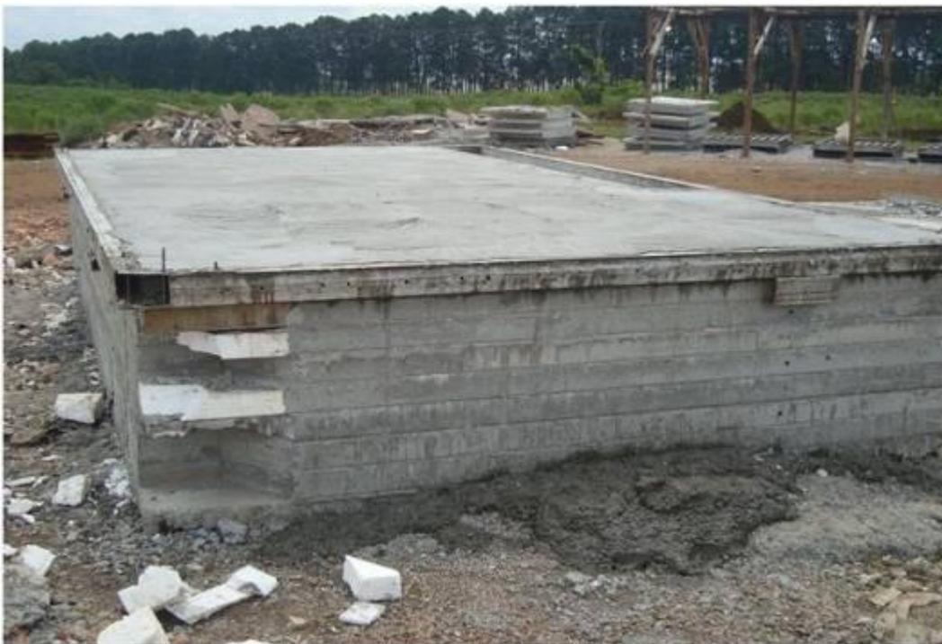
**Foto 6.1 – Laje já concretada, pronta para a desforma.**
