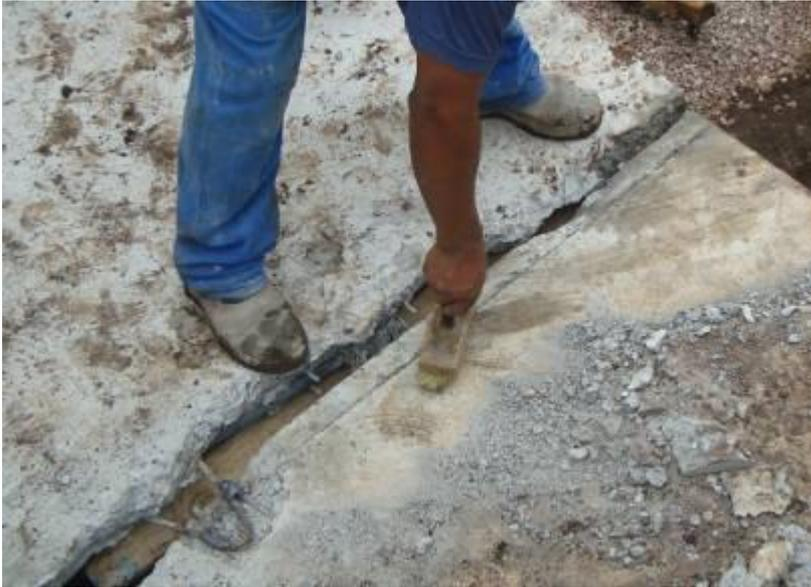
**Foto 20.1 – Limpeza das impurezas para a colocação da argamassa**
