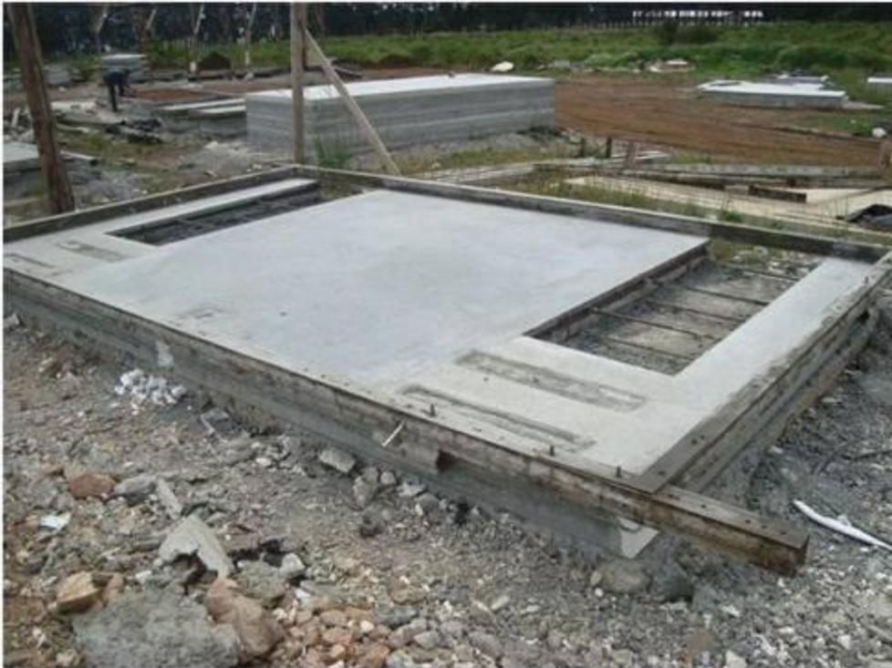
Foto 7.1 – Perfil/molde alumínio, pronta pra ser colocada as armações
