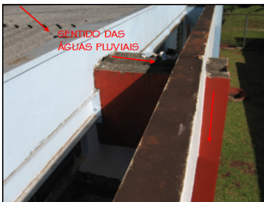
Figura 14 - Viga calha – laboratório de Química / Física Fonte: Elaborado pelo autor, 2010
