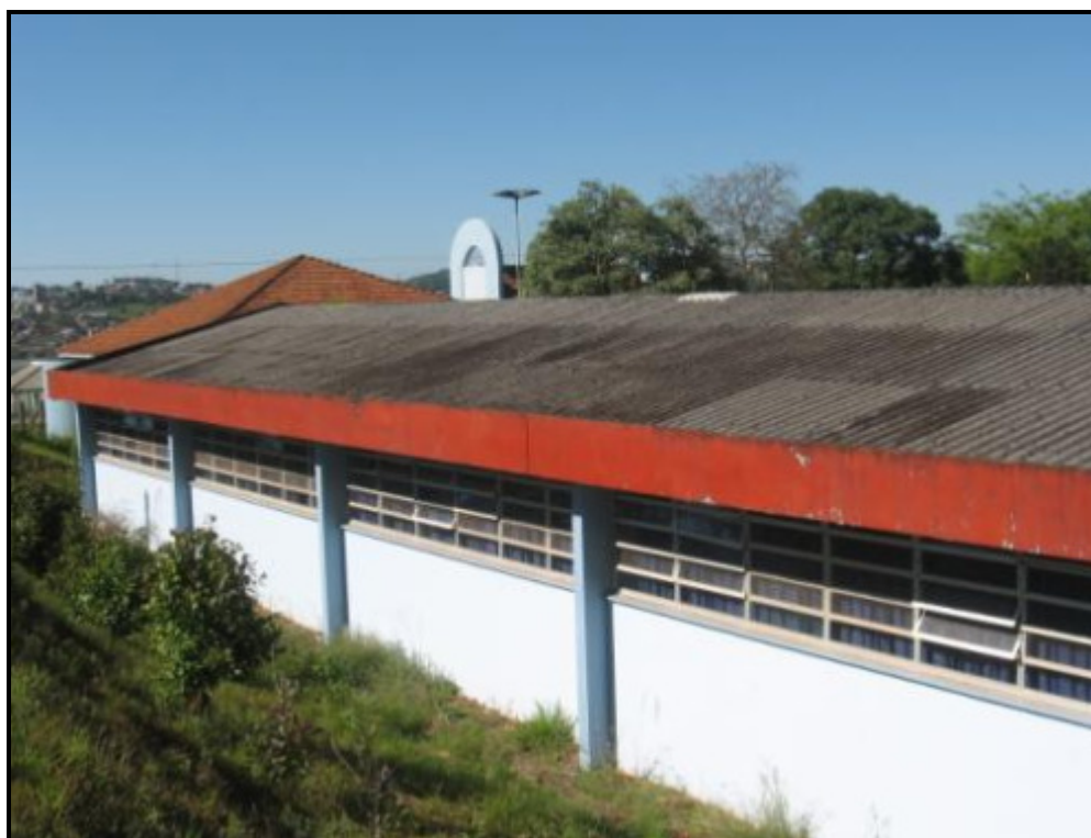
Figura 17 - Cobertura - Externo bloco 5 Fonte: Elaborado pelo autor, 2010
