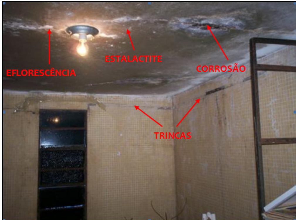
Figura 9 - Depósito anexo ao laboratório de Química / Física Fonte: Elaborado pelo autor, 2010
