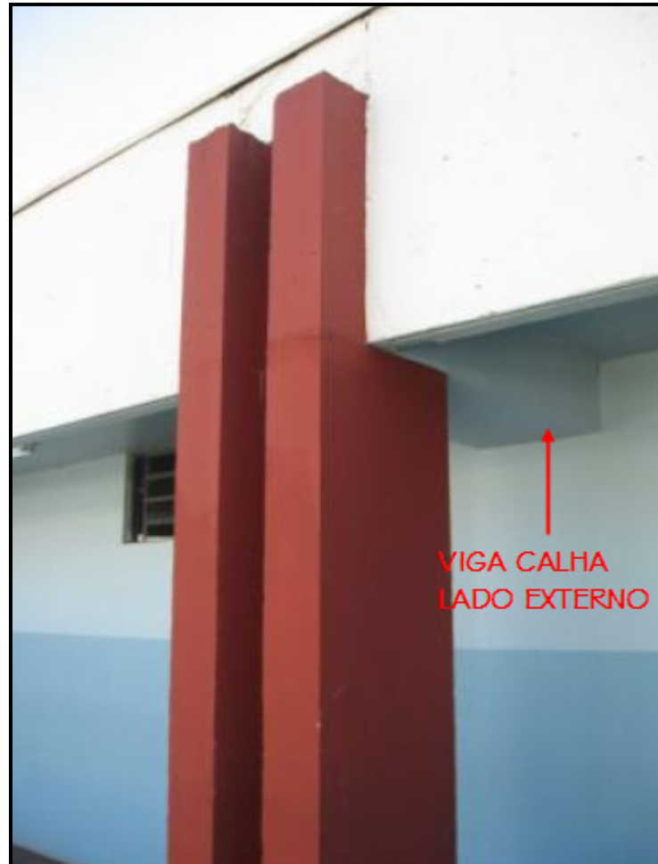
Figura 16 - Viga calha - lado externo laboratório de Química / Física Fonte: Elaborado pelo autor, 2010
