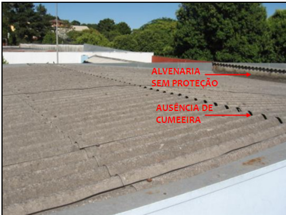
Figura 13 - Cobertura do laboratório de Química / Física Fonte: Elaborado pelo autor, 2010
