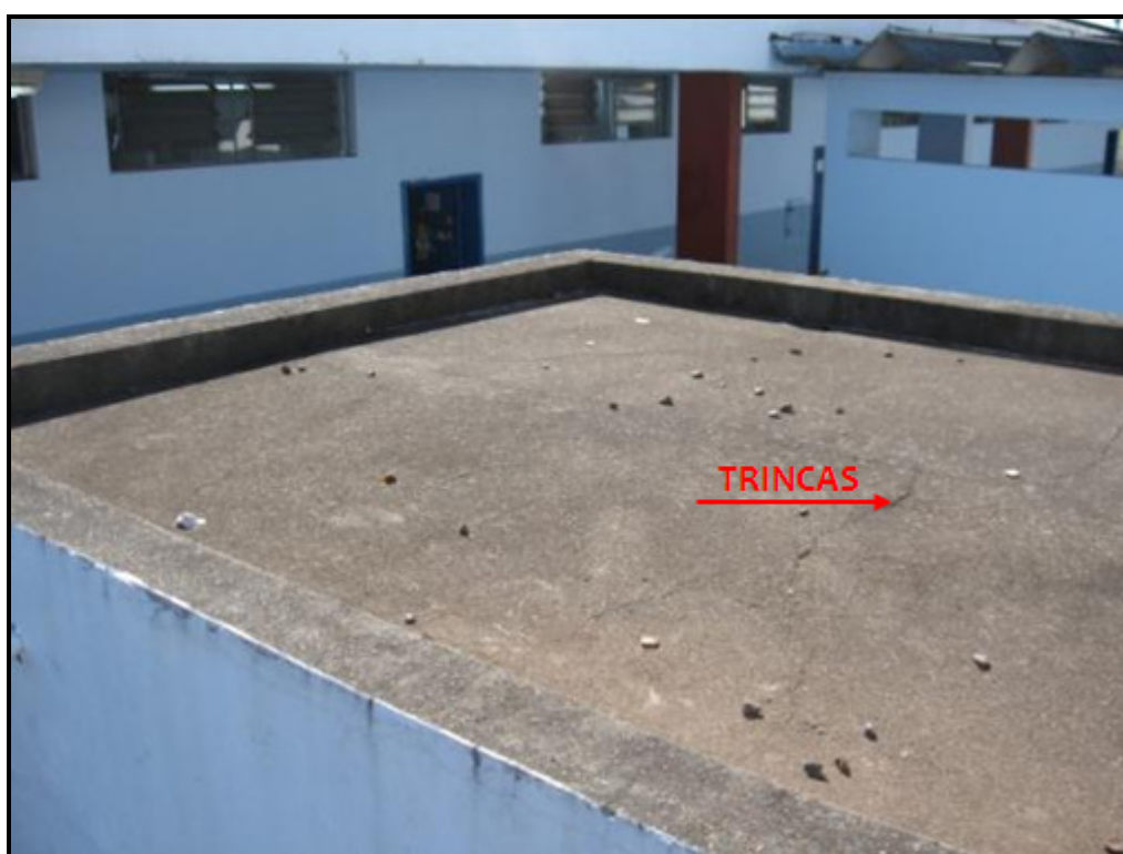
Figura 8 - Laje de cobertura do depósito anexo ao laboratório de Química / Física Fonte: Elaborado pelo autor, 2010
