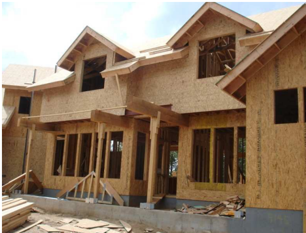
Figura 5: Construção em light wood framing Fonte: framingexperts.co.uk
