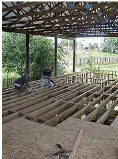
Figura 18: Barroteamento piso Fonte: lpbrasil.com.br
