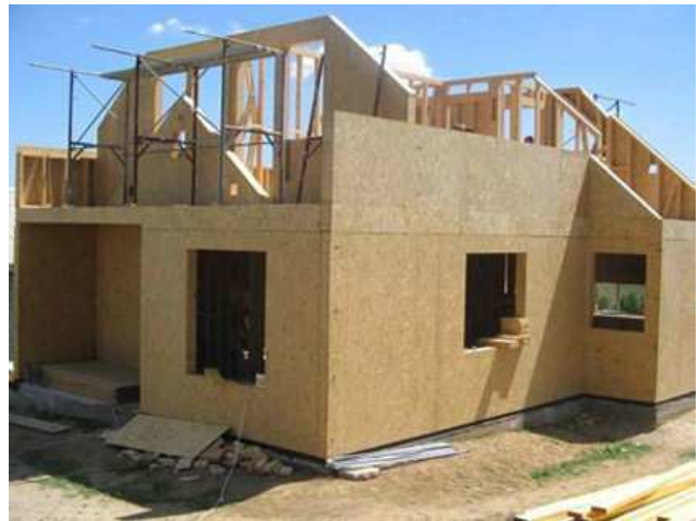
Figura 6: Construção em light wood framing Fonte: framingexperts.co.uk
